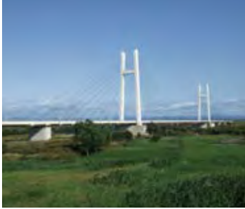
●岩見沢大橋(斜張橋)
