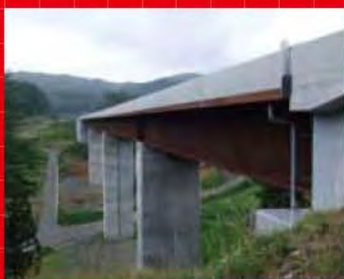
●白土川橋(連続版桁)
