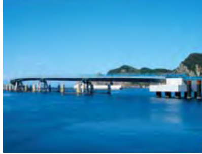
●追直漁港橋梁(鋼床版箱桁)
