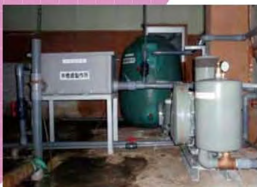
水産加工場 水産加工場における有機廃水や 殺菌剤等が含まれた排水の処理 設備です。
