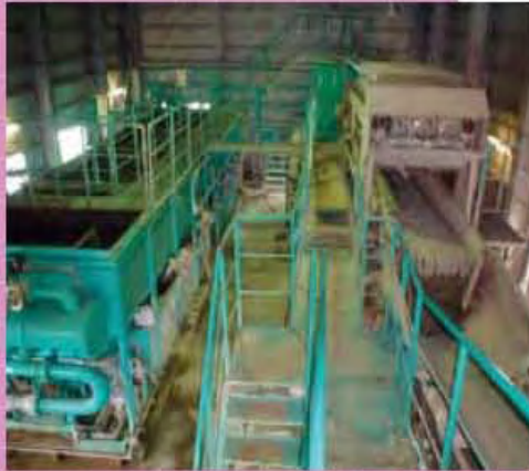
ホタテカゴ洗浄 排水処理装置 養殖用のホタテカゴの洗 浄排水を浄化処理する 装置です。
