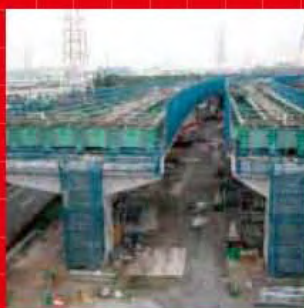
●東海料金所工区(連続版桁)
