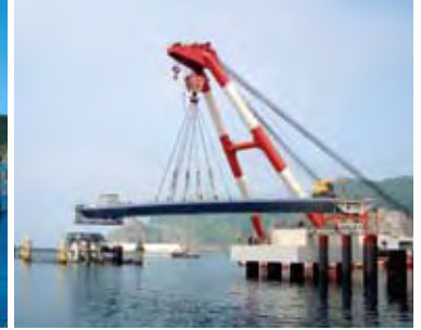
●追直漁港橋梁(500Tフローティングクレーン架設)
