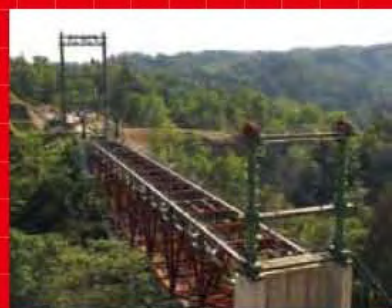
●遠別橋(トラス橋・ケーブルエレクション架設)
