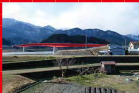
●新南部橋(鋼床版箱桁)
