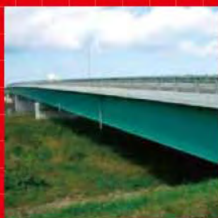
●岩瀬橋(連続箱桁)
