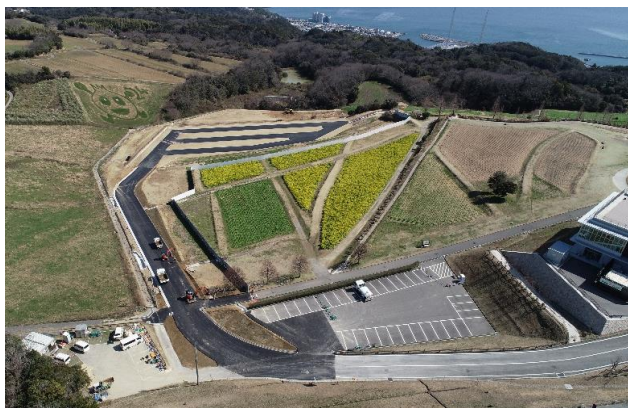
兵庫県農林水産部／駐車場整備工事／駐車場新設，整備面積(進入路・遊歩道含む)約9800㎡・整備台数208台
