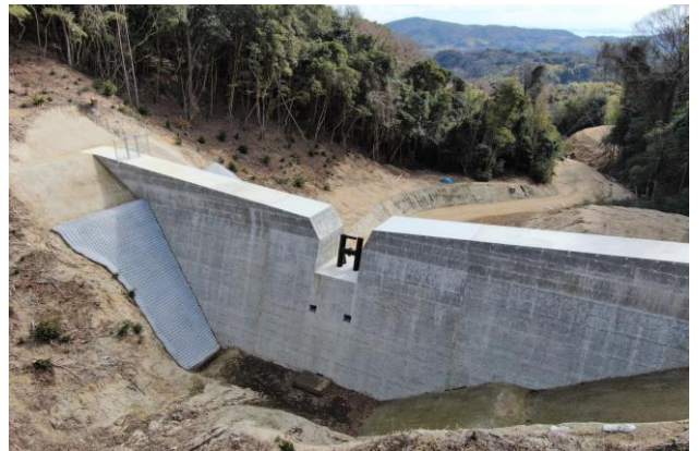
淡路県民局洲本土木事務所／通常砂防事業／砂防堰堤工，鋼製スリット工，土工，付替里道工 2022
