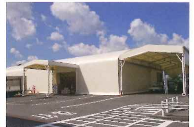
テント倉庫テント貼り替え
