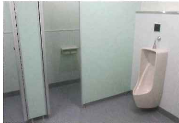
工場内トイレ設置
