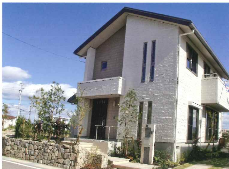
外構工事 (多治見市)
