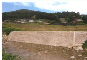
崩れた護岸の補修
