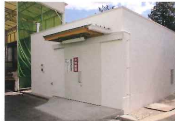
危険物倉庫改築
