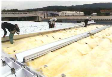
屋根のダブルバッキング工法
