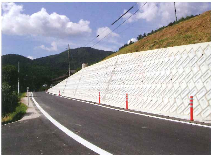
インフラ整備（路肩の補強や、落石防護の柵等）
