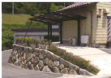
自然石を使った野面積み工法 (白川町)
