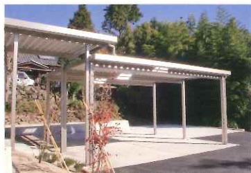
カーポート施工 (中津川市)
