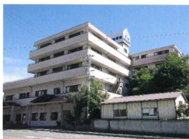
小南病院白浜増築工事
