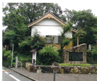
清姫堂建立工事
