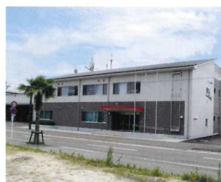
白浜町消防庁舎
