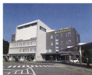
紀南看護学校(JV工事)
