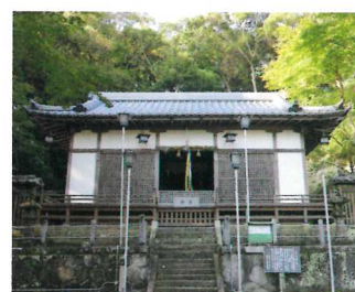
堅田八幡神社社殿修復工事
