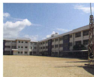
富田中学校耐震改修等工事
