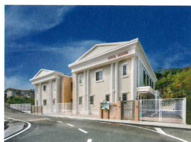
堅田保育園新築工事
