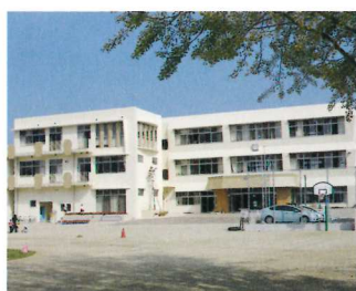
白浜町立北富田小学校 校舎建設工事
