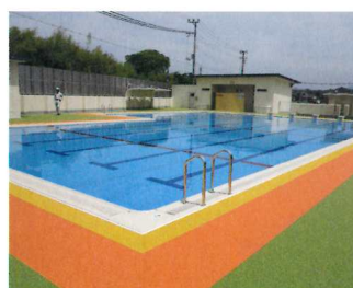
白浜町立北富田小学校 プール建設工事
