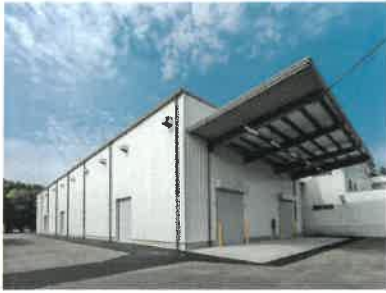
株式会社エフピコ様 下館第三工場倉庫新築工事 令和3年10月完成（茨城県筑西市）
