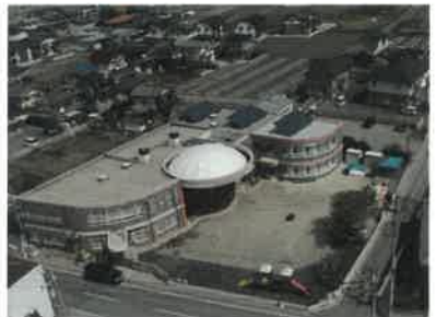
三田保育園様 増築工事 平成27年2月完成（茨城県古河市）
