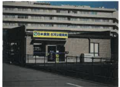
日本調剤古河公園薬局様 新築工事 平成29年10月完成（茨城県古河市）
