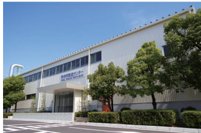
中外炉工業(株)堺事業所熱技術創造センター増築工事
