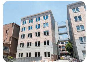
京都大学(中央)文系学部校舎 改修その他工事
