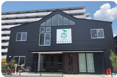
草の根共生会 蓮Ⅱ 新築工事
