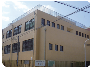
東大阪市立長瀬青少年センター 耐震補強その他改修工事
