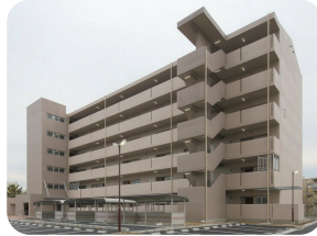
大阪府営堺若松台2丁 第2期高層住宅(建て替え) 新築工事(第2工区)
