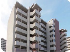
大阪府営門真千石町 第一期高層住宅新築工事
