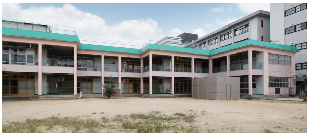
近畿大学 東大阪キャンパス22号棟一般・耐震改修工事
