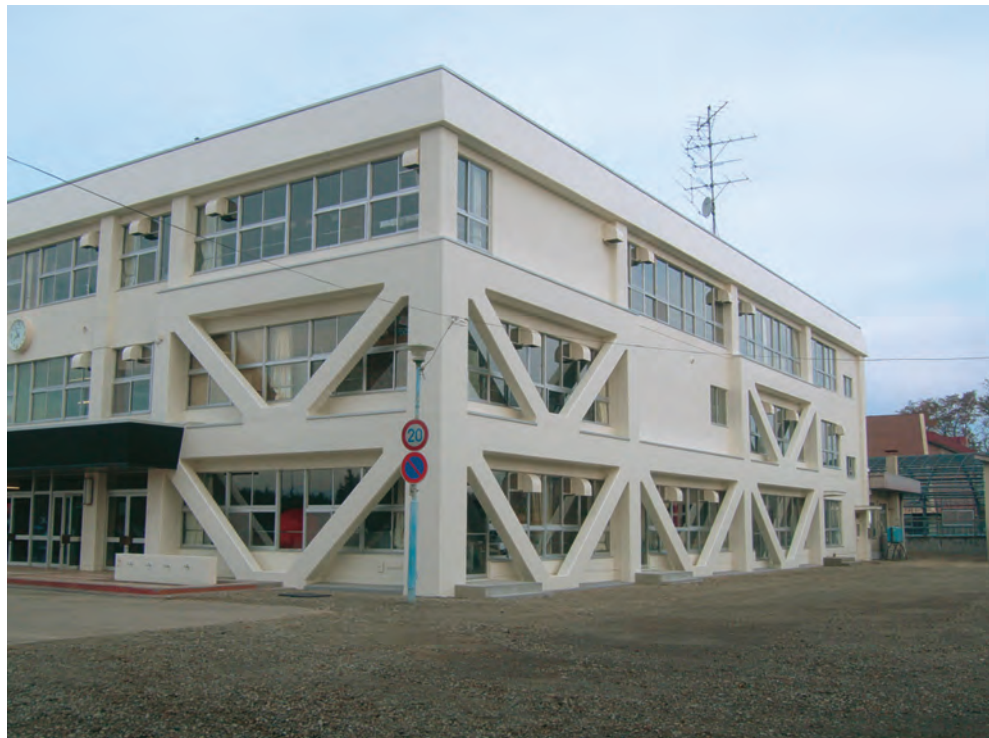
木野東小学校耐震 ■発注者／音更町 ■所在地／音更町 ■竣工／平成19年
