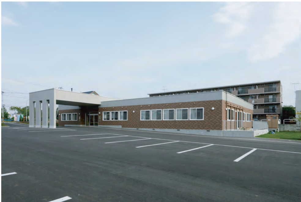
デイサービスセンター愛仁園 ■発注者／（株）普仁会 ■設計者／協和・TC ■所在地／帯広市 ■竣工／平成23年
