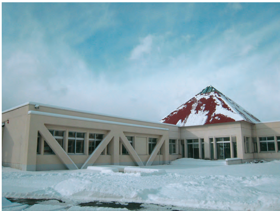
東神楽町立東神楽小耐震補強 ■所在地／東神楽町 ■竣工／平成20年
