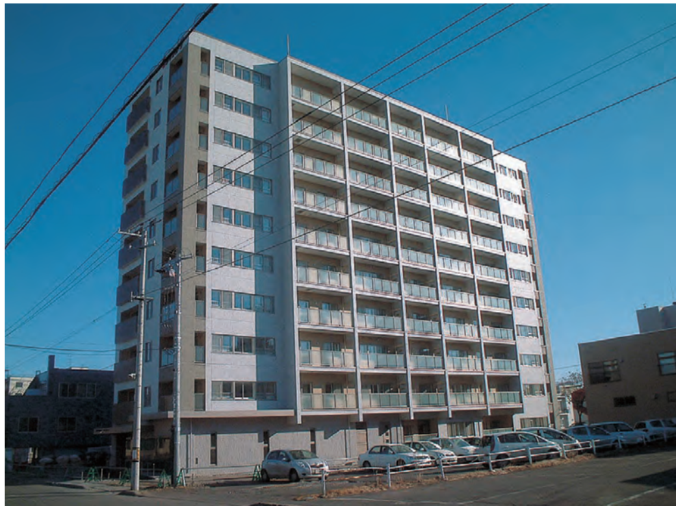
NCウイング7 ■発注者／NCおびひろ ■設計者／創建社 ■所在地／帯広市 ■竣工／平成18年
