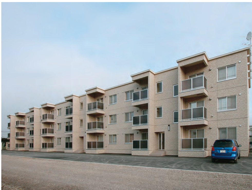
北海道糖業(株)社宅 ■発注者／北海道糖業(株) ■設計者／宮坂建設工業 ■所在地／本別町 ■竣工／平成20年
