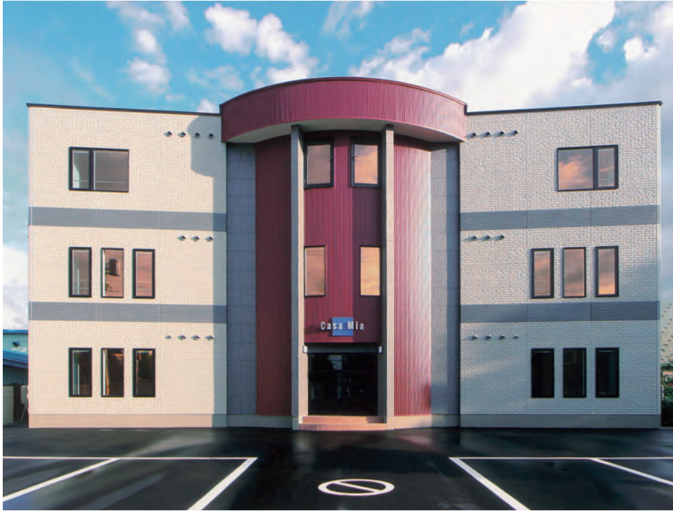
前田マンション ■発注者／前田悦子 ■設計者／建築設計事務所トポス ■所在地／帯広市 ■竣工／平成17年
