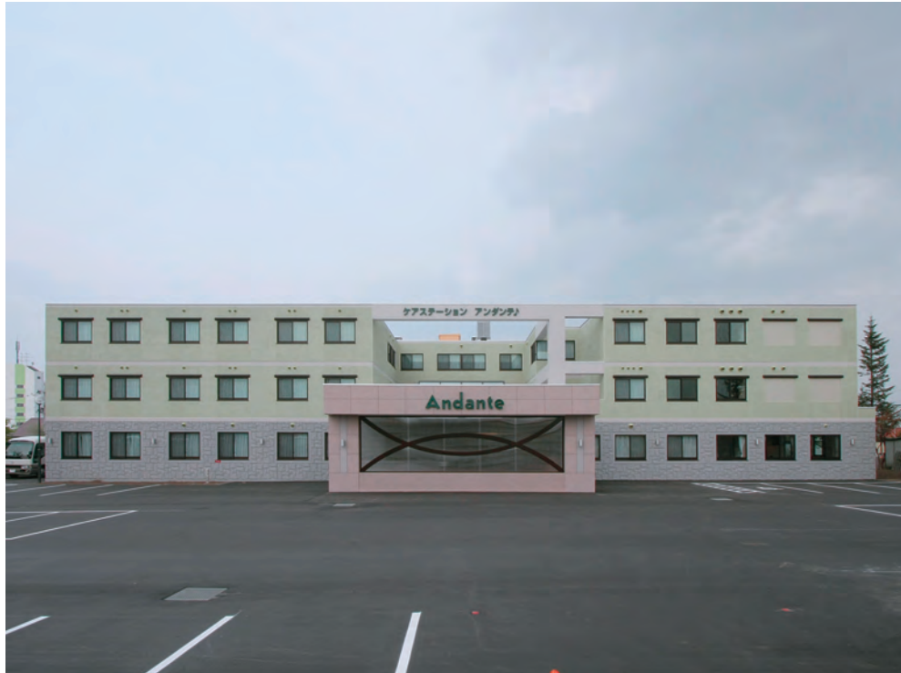
アンダンテ ■発注者／社会福祉法人光寿会 ■設計／環境企画工房 ■所在地／帯広市 ■竣工／平成20年
