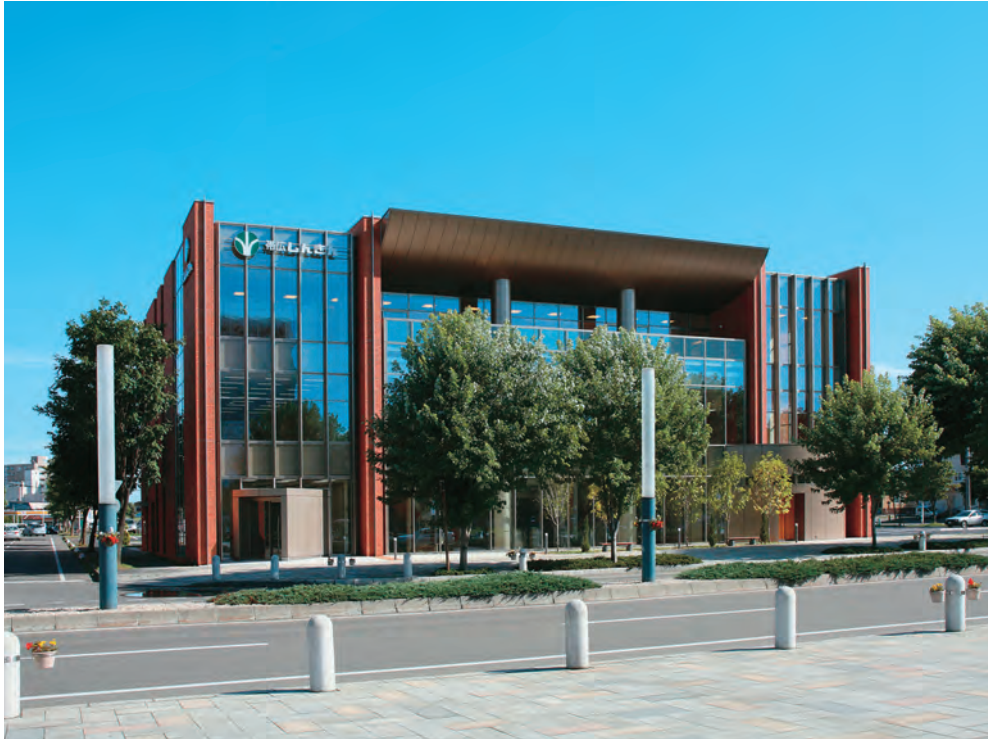
帯広信用金庫中央支店 ■発注者／帯広信用金庫 ■設計者／環境設計・創造設計舎 ■所在地／帯広市 ■竣工／平成21年
