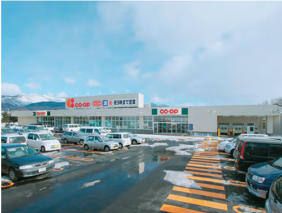
CRE伊達商業施設 ■発注者／コマースアルレー ■設計者／マキタ設計 ■所在地／伊達市 ■竣工／平成20年
