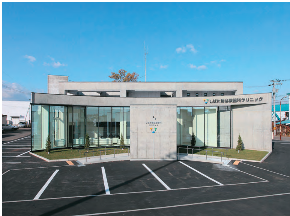
しばた腎泌尿器科 ■発注者／柴田武 ■設計者／トータルプロデュース ■所在地／帯広市 ■竣工／平成21年
