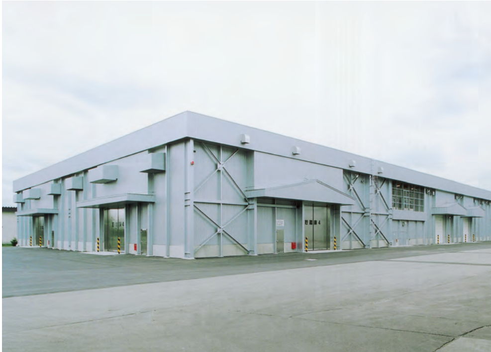
音更農協玉葱他施設 ■発注者／JA音更 ■設計者／ホクレン農業協同組合連合会 ■所在地／音更町 ■竣工／平成16年
