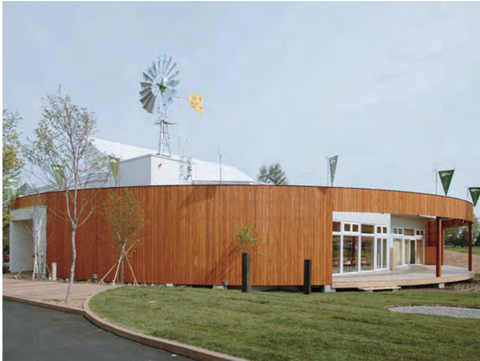
満寿屋麦音店 ■発注者／(株)満寿屋商店 ■設計者／象設計集団 ■所在地／帯広市 ■竣工／平成21年
