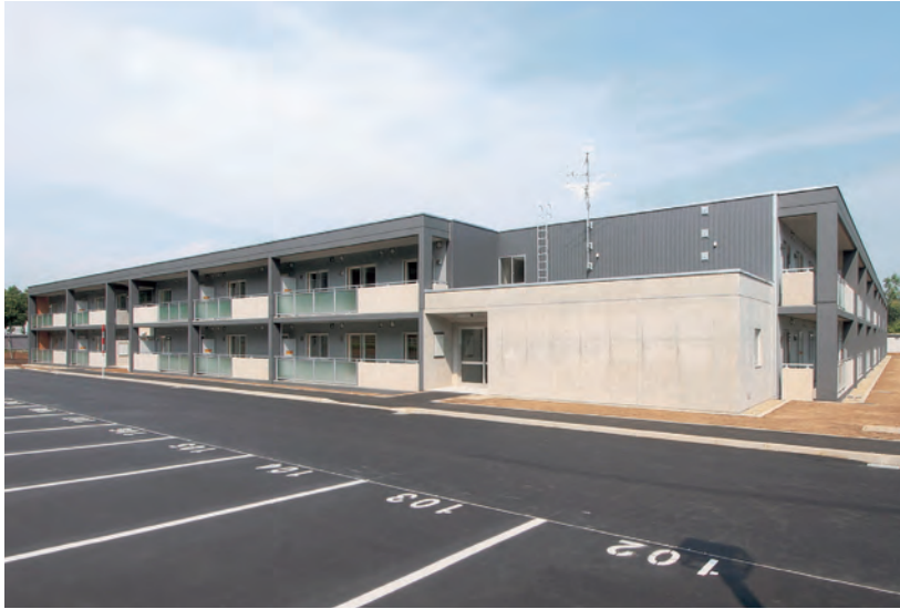
道営とかち野団地 ■発注者／北海道 ■設計者／北海道建設部住宅局 ■所在地／幕別町 ■竣工／平成18年
