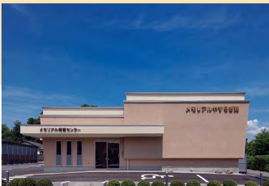
メモリアルやすらぎ館新築工事
