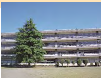
秩父市立第二中学校A棟 大規模改修工事 (秩父市)
