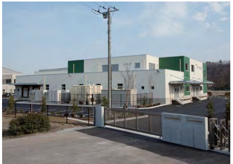
北部共同調理場建設工事 (秩父市)
