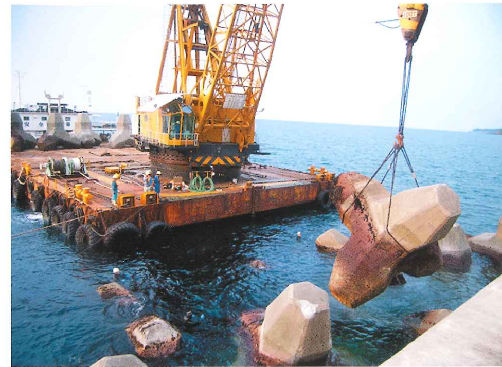
泊漁港整備工事(第2沖防波堤被覆・消波ブロック設置)
