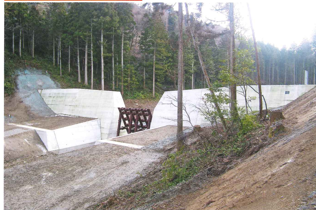
納谷川災害関連緊急砂防堰堤工事（2工区）
