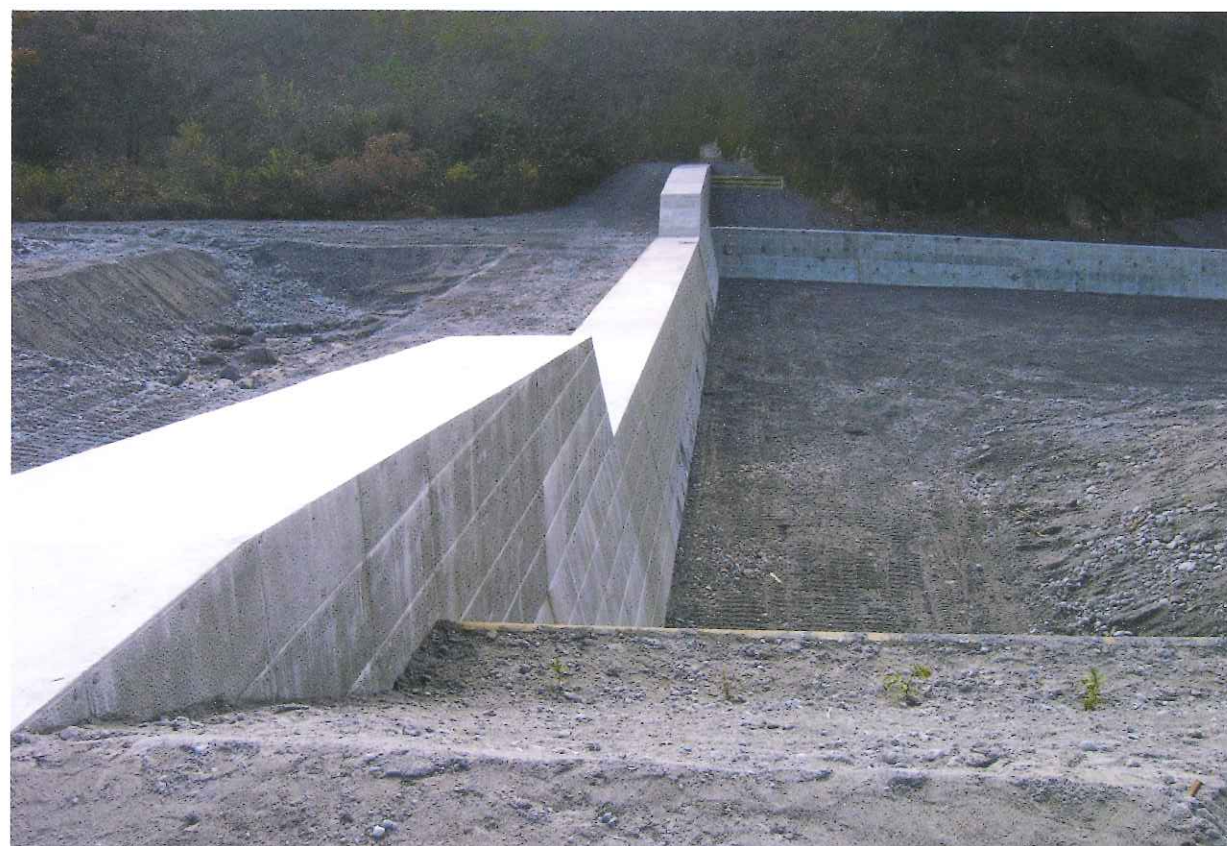
大山（佐陀川）第34-2号床固外工事
