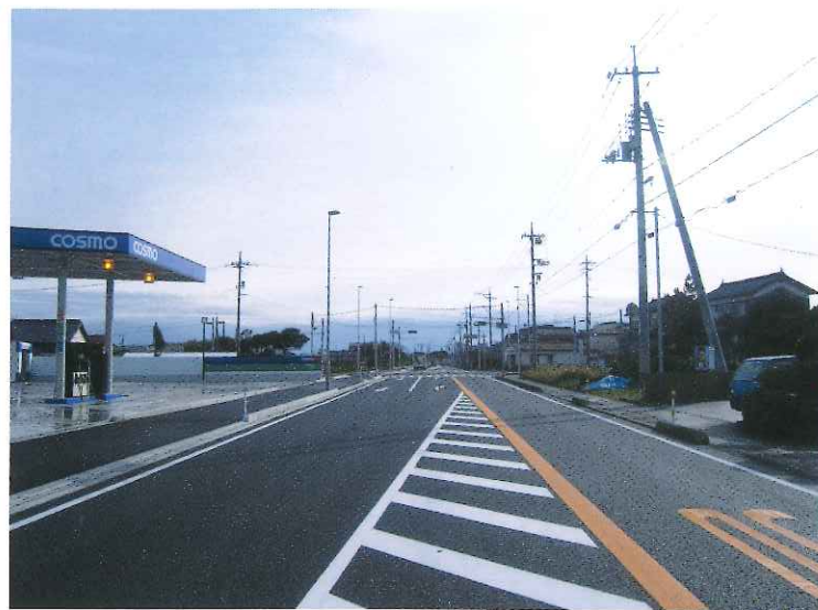
国道9号赤碓地区舗装工事
