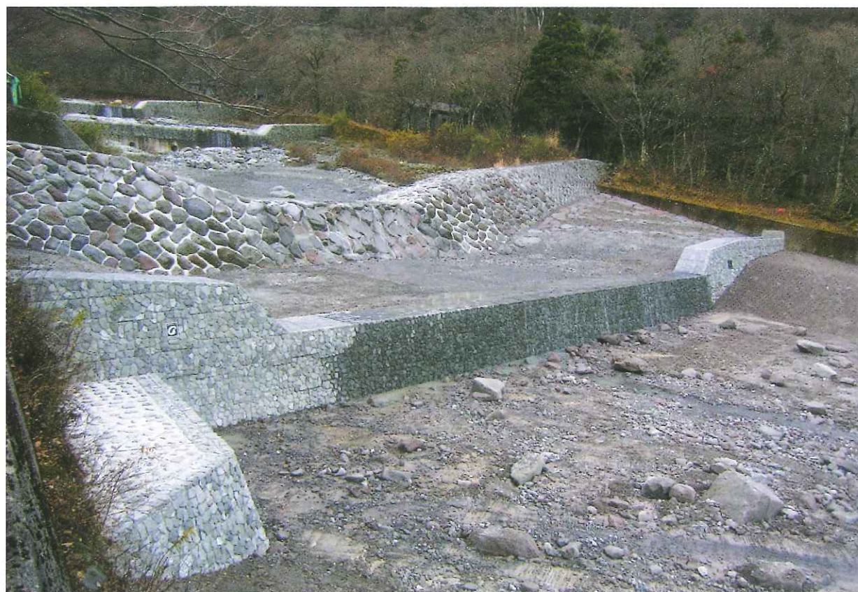
大山（佐陀川）第11号えん堤施設災害対策工事
