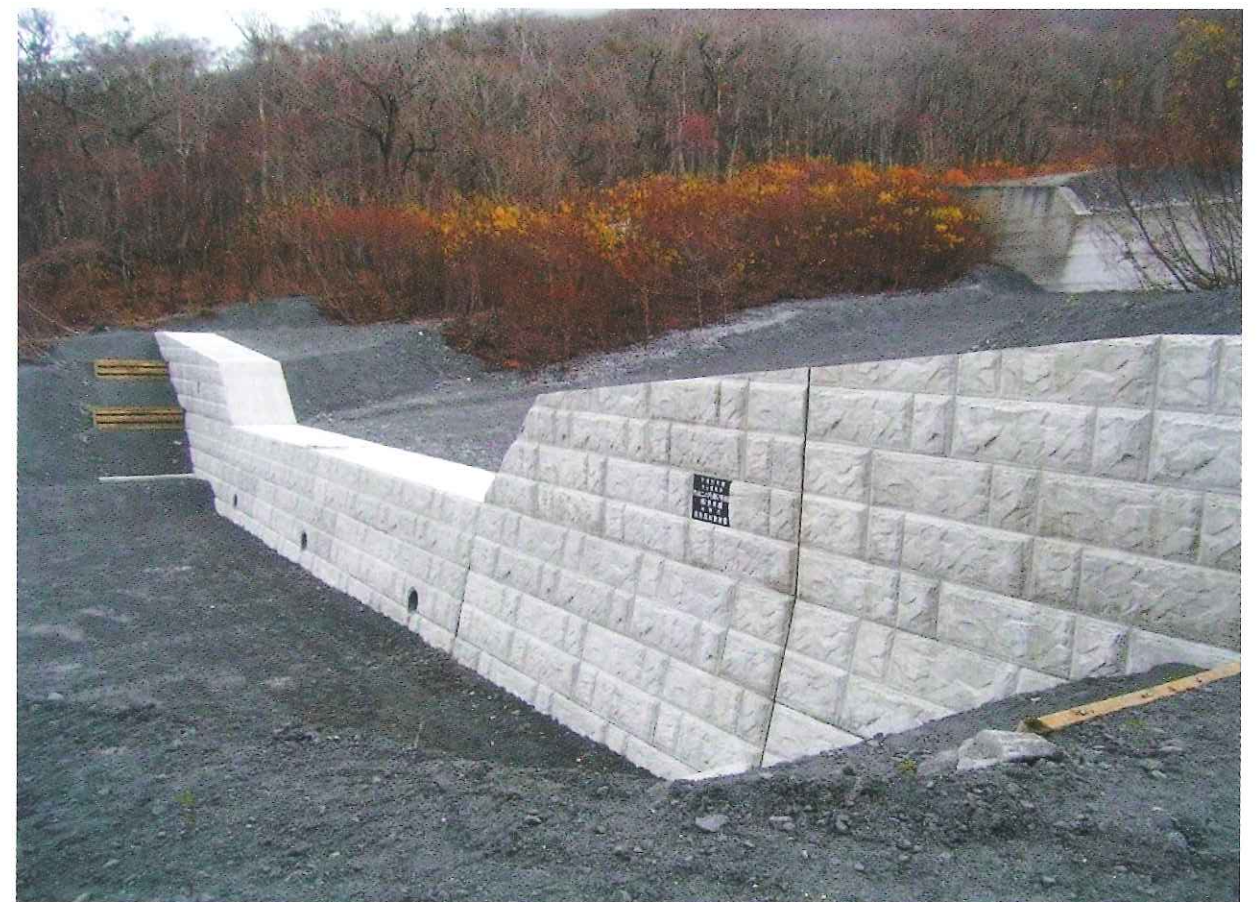
大山（二の沢）第17号床固工事
