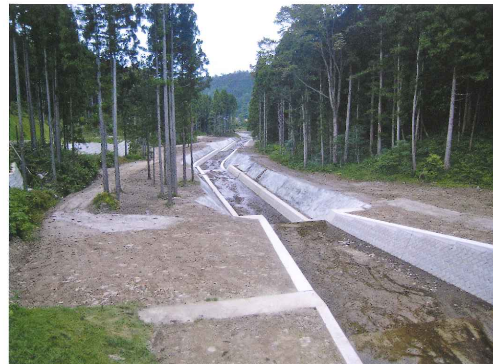
納谷川特定緊急砂防堰堤工事（1工区）
