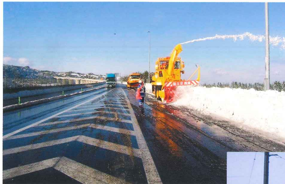
東部保守工事 除雪作業
