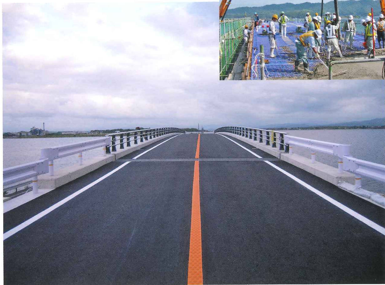
中海干拓事業森山堤橋梁上部工他工事
