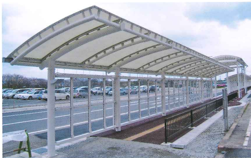
美保飛行場道路駐車場歩道ルーフ設置等工事
