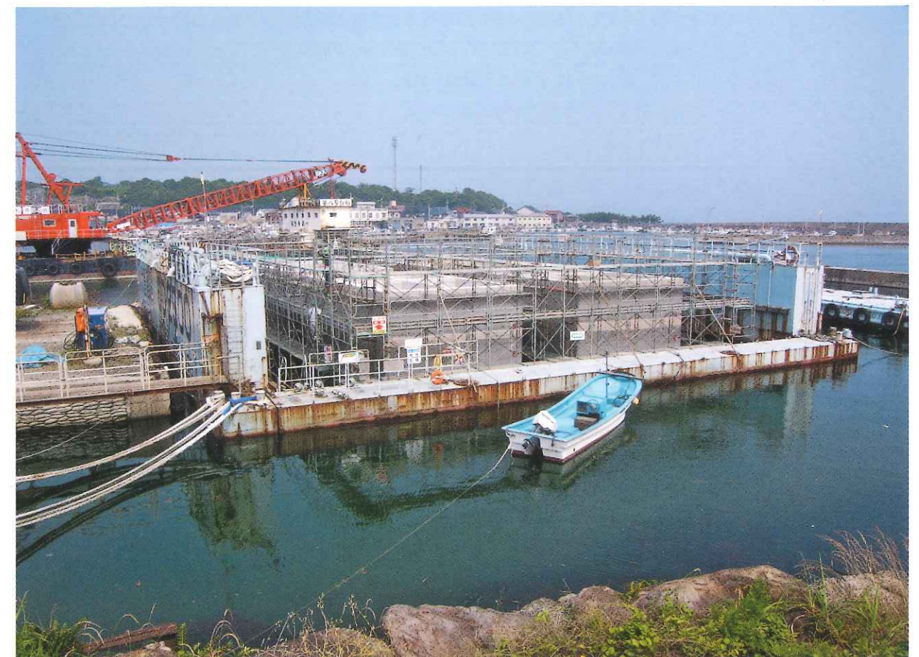
赤碕港改修工事(防波堤第3)
