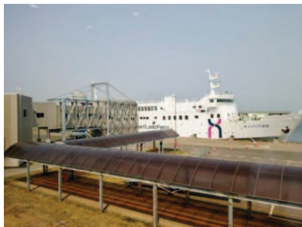
稚内フェリーターミナル ボーディングブリッジA整備工事（稚内市）
