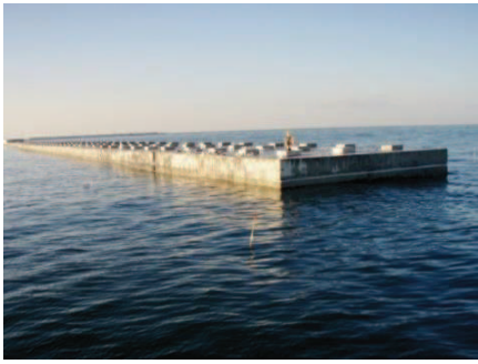
釧路港新西防波堤建設工事（釧路市）
