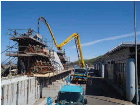
香深港外1港建設工事（礼文町）
