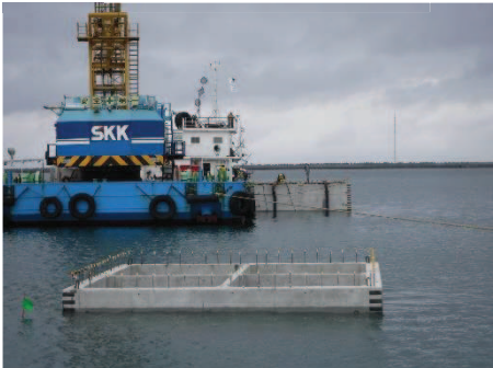
稚内港ケーソン製作その他工事（稚内市）
