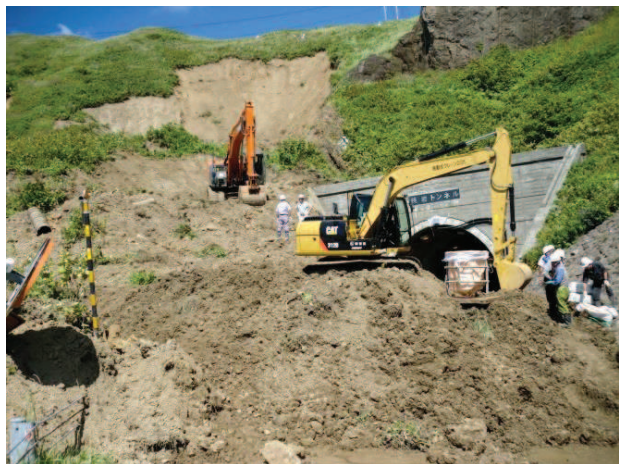
礼文島元地地区土砂崩落災害復旧（礼文町）
