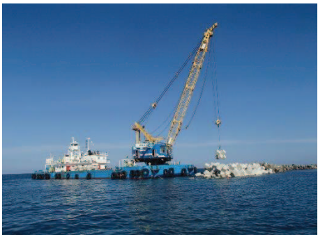
元稲府漁港北防波堤建設その他工事（雄武町）
