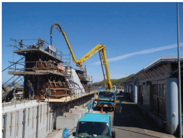
香深港外1港建設工事（礼文町）
