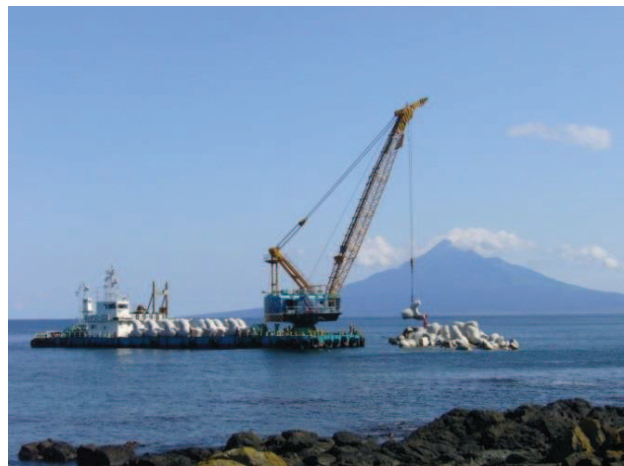
礼文内路漁港整備工事（礼文町）
