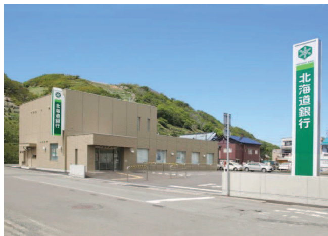
北海道銀行 稚内支店新築工事（稚内市）
