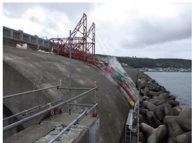
稚内港北防波護岸改良その他工事（稚内市）
