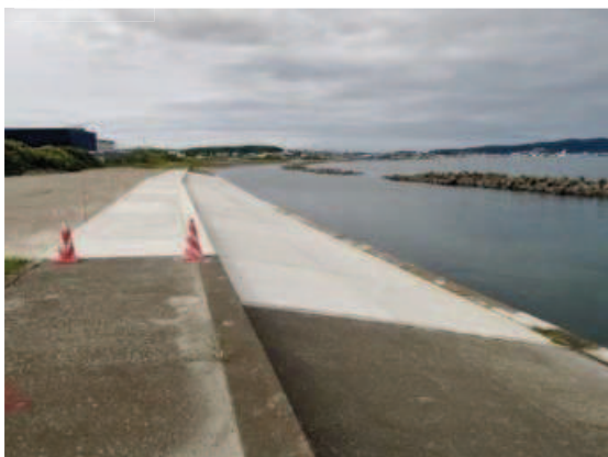
潮見地区護岸整備工事（稚内市）
