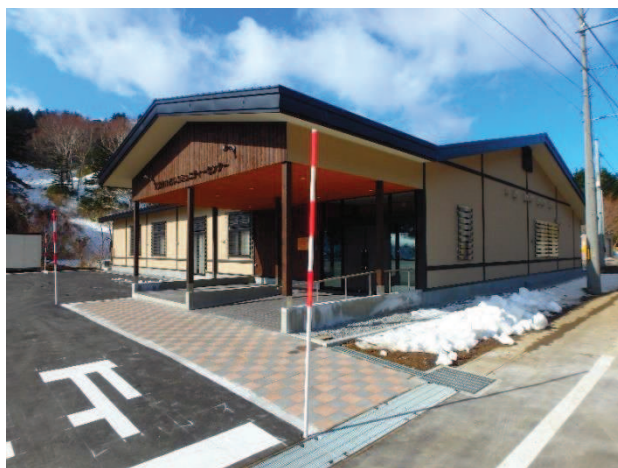
礼文町ふれあいコミュニティーセンター 新築工事（礼文町）
