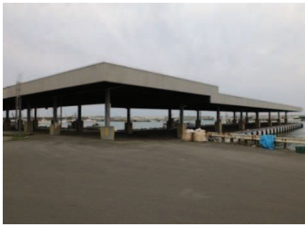
苫前漁港衛生管理施設建設工事（苫前町）
