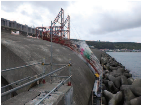
稚内港北防波堤護岸改良その他工事（稚内市）
