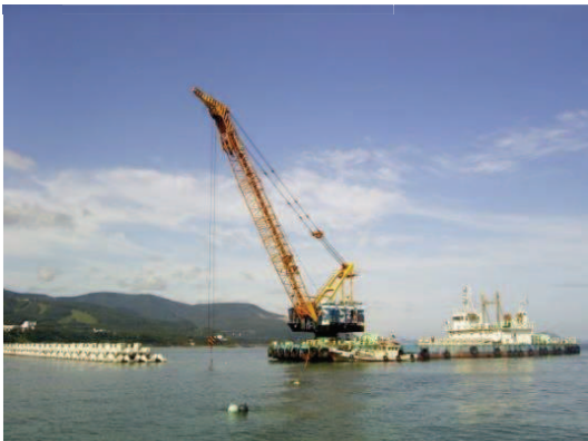
銭函海岸浸食対策工事（小樽市）
