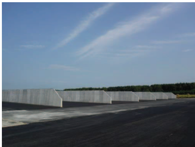
畜産担い手総合整備事業幌延西部地区（幌延町）
