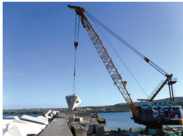
杓形港外防波堤災害復旧その他工事（利尻町）
