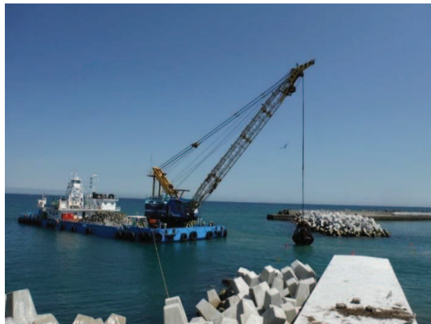
知来別漁港水産生産基盤整備工事（猿払村）
