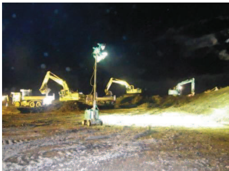
稚内空港滑走路端安全区域造成工事（稚内市）
