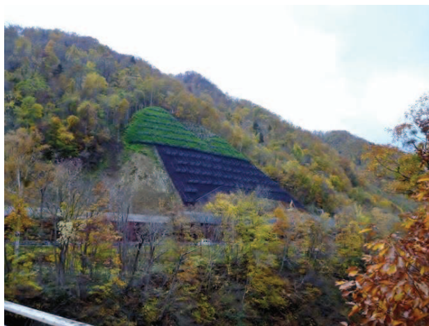
札幌230号百松改良工事（札幌市）
