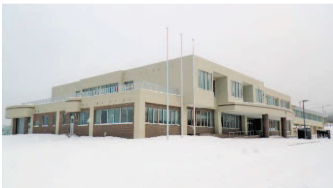
利尻町立中学校建設工事（利尻町）
