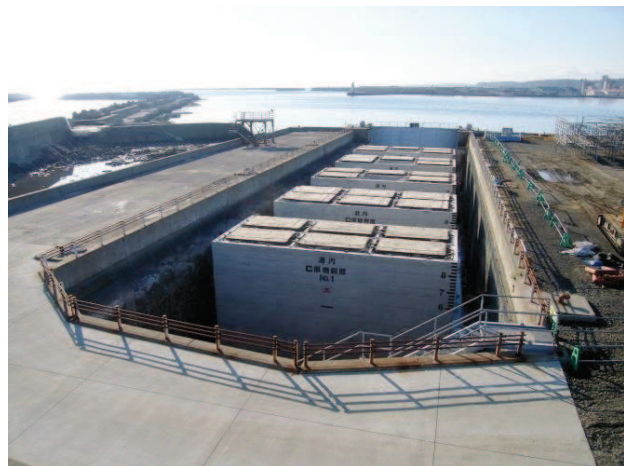
網走港ケーソン製作工事（網走市）
