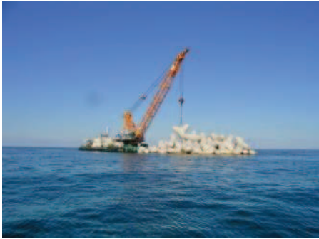
須古頓漁業水産物供給基盤整備工事（礼文町）
