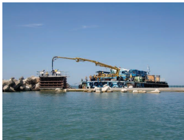
抜海漁港防砂堤工事（稚内市）
