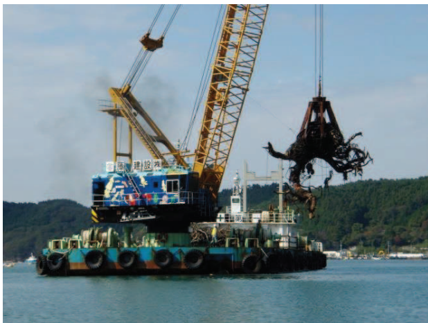
震災復旧作業（石巻市）
