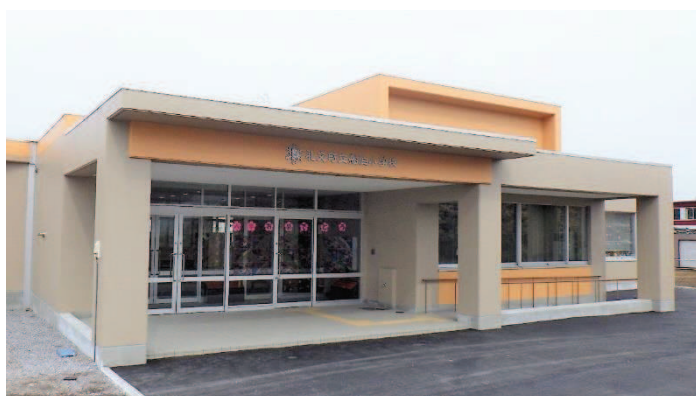
船泊小学校校舎改築工事（礼文町）
