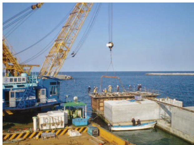
宗谷港建設工事（稚内市）
