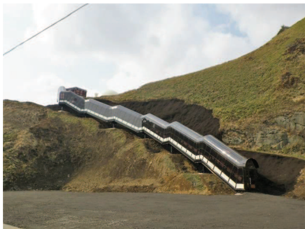
起登臼避難路・防災備蓄庫設置工事（礼文町）
