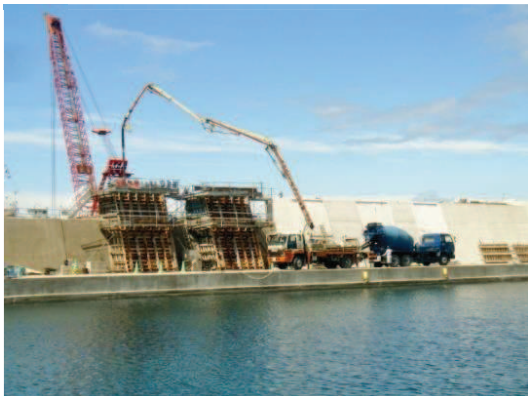
白神漁港機能強化工事（松前町）
