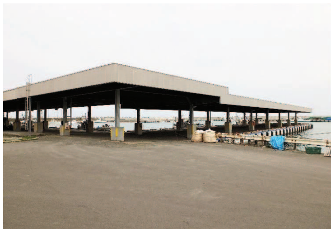
苫前漁港衛生管理施設建設工事 （苫前町）
