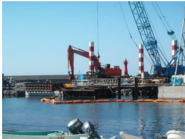
礼文西漁港建設工事（礼文町）
