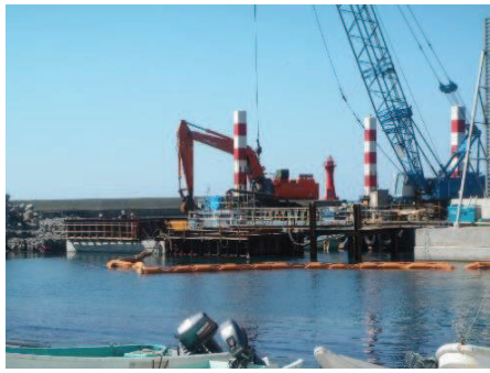
礼文西漁港建設工事（礼文町）
