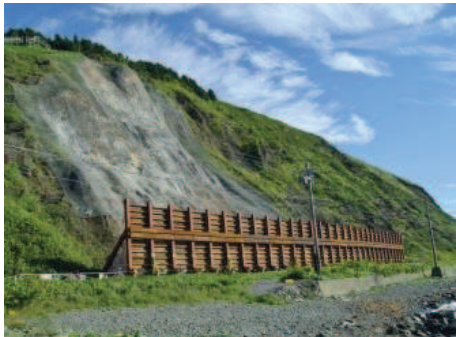
礼文島線交付金全国防災工事（礼文町）
