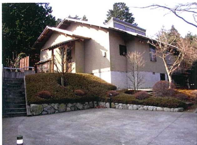
H邸 [静岡県田方郡函南町]
