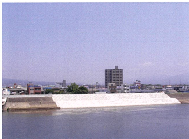
狩野川日吉護岸工事 [静岡県沼津市]
