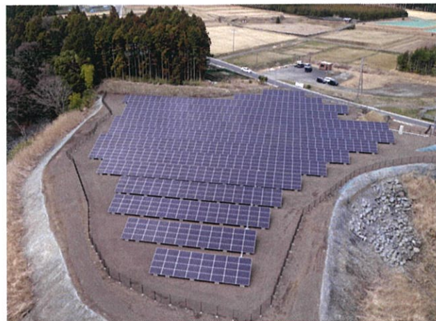
太陽光発電システム設置工事 [静岡県裾野市]
