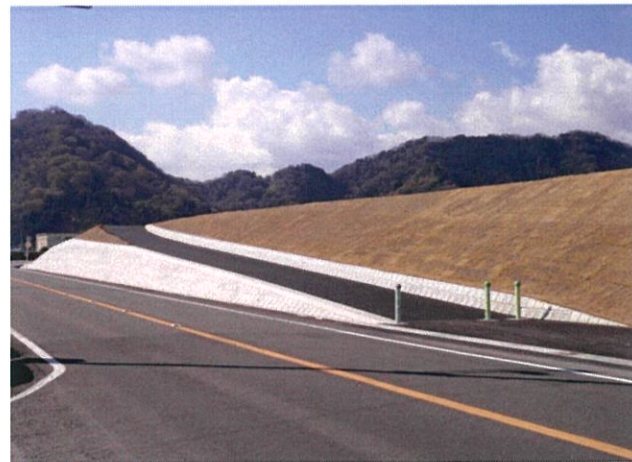
狩野川肥田築堤工事 [静岡県田方郡函南町]
