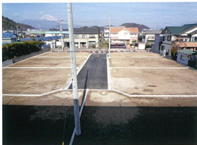
徳倉分譲地宅地造成工事 [静岡県駿東郡清水町]
