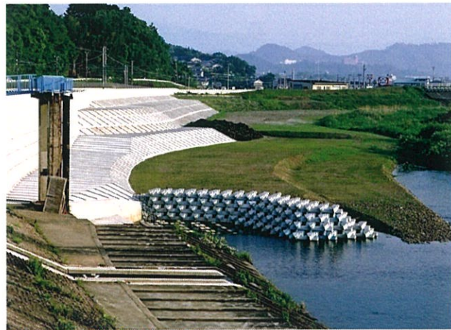
狩野川南条護岸工事 [静岡県伊豆の国市]
