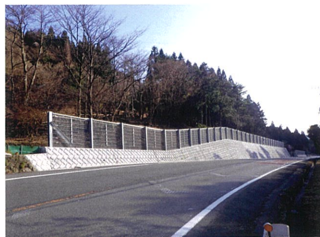
沼津河川国道管内防災工事 [静岡県駿東郡小山町]
