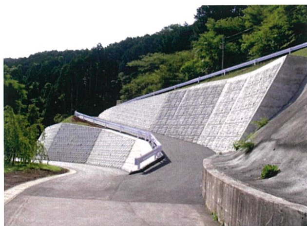
国立駿河療養所擁壁整備工事 [静岡県御殿場市]
