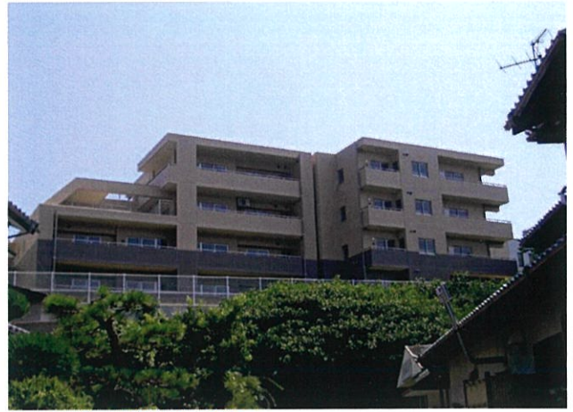
アーバン浜松山手町 [静岡県浜松市]
