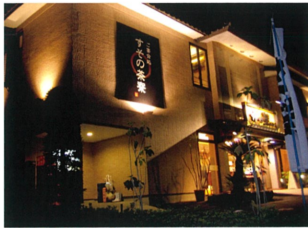
かつ栄裾野店、すその茶寮店舗改修 [静岡県裾野市]
