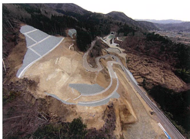
天城北道路日向地区下部工事 [静岡県伊豆市]
