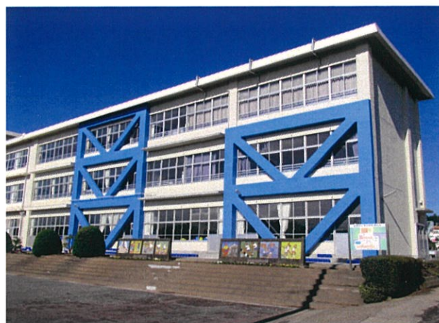
裾野市立東小学校大規模改修 [静岡県裾野市]
