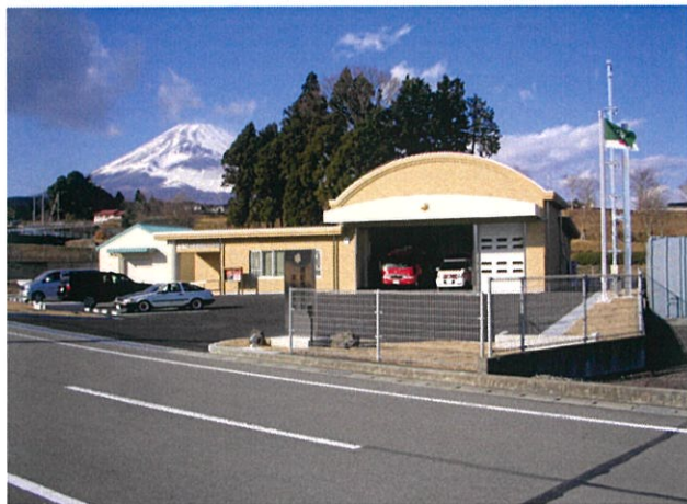
裾野市消防署須山分遣所 [静岡県裾野市]
