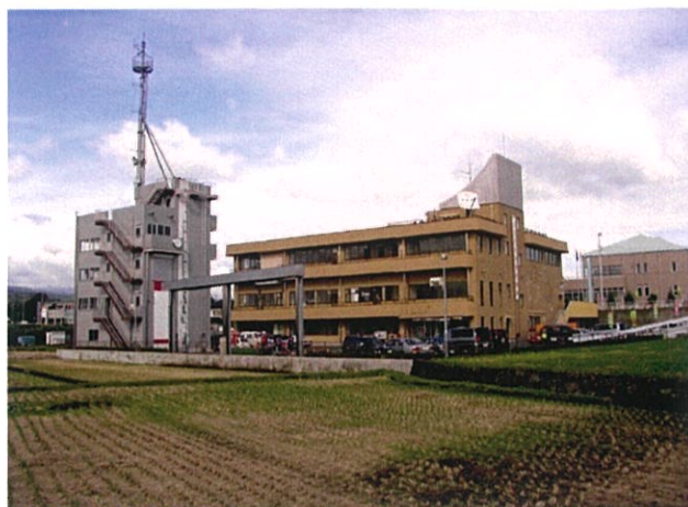
裾野市消防庁舎 [静岡県裾野市]
