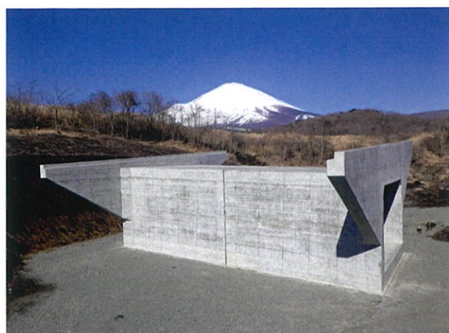
御殿場維持管内道路建設工事 [静岡県駿東郡小山町]
