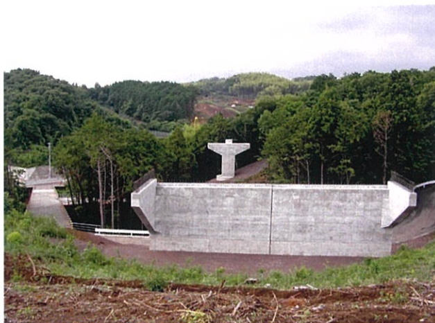
伊豆縦貫塚原高架橋下部工事 [静岡県三島市]
