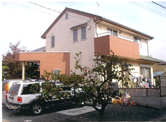
H邸 [静岡県伊豆の国市]
