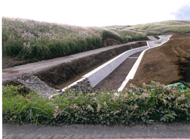
金沢川流路工事 [静岡県裾野市]
