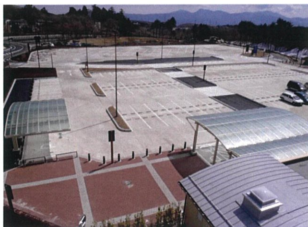
須走地区道路改良工事(道の駅) [静岡県駿東郡小山町]
