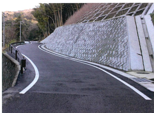
天城北道路矢熊地区道路建設工事 [静岡県伊豆市]
