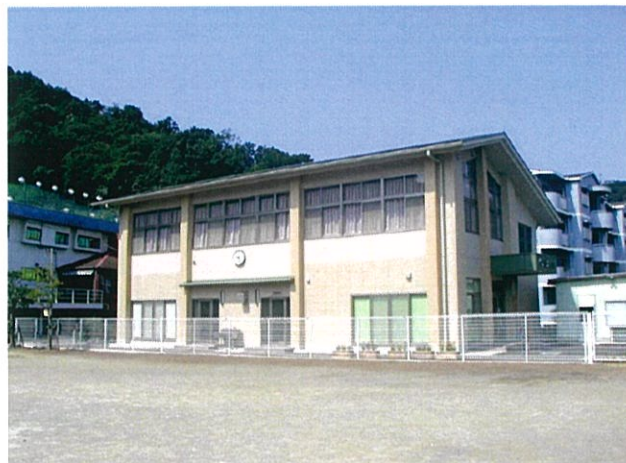
清水町外原区公民館 [静岡県駿東郡清水町]
