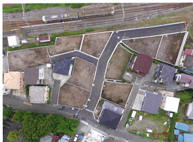
岩波宅地造成工事 [静岡県裾野市]
