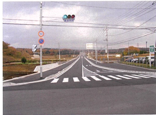
南外周道路外 道路改良舗装工事 [静岡県裾野市]
