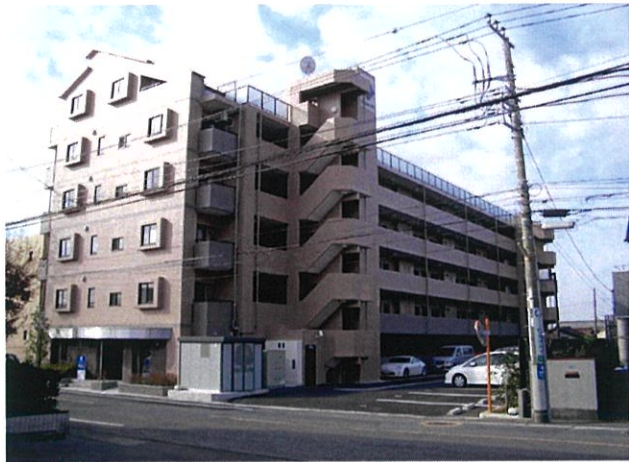
アーバン沼津新沢田町 [静岡県沼津市]
