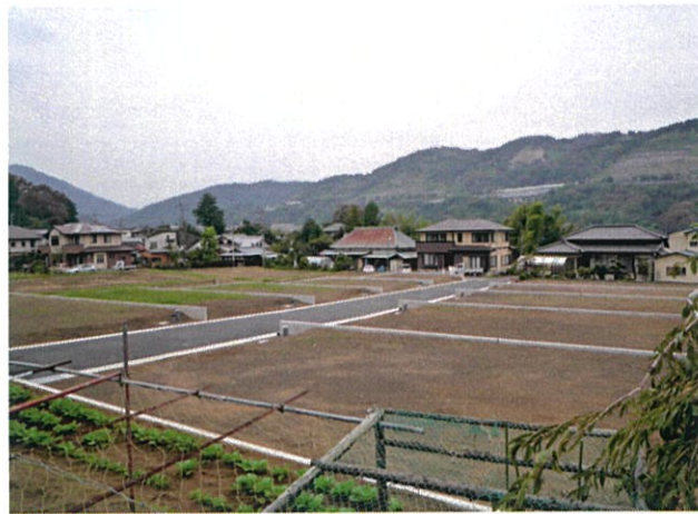
山北分譲地宅地造成工事 [神奈川県足柄上郡山北町]
