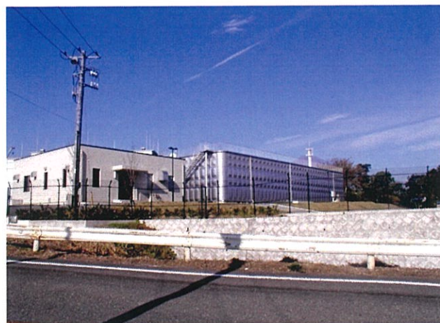
新小鍋配水場築造工事 [静岡県裾野市]
