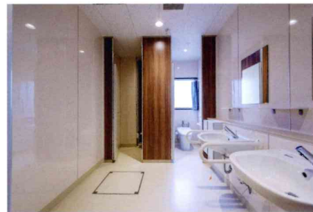
本庄市立藤田小学校トイレ改修 本庄市 令和2年度本庄市優秀請負業者表彰
