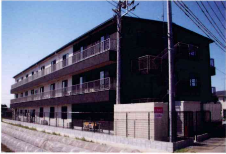
サービス付き高齢者向け住宅 ユーオーディア壱番館 深谷市
