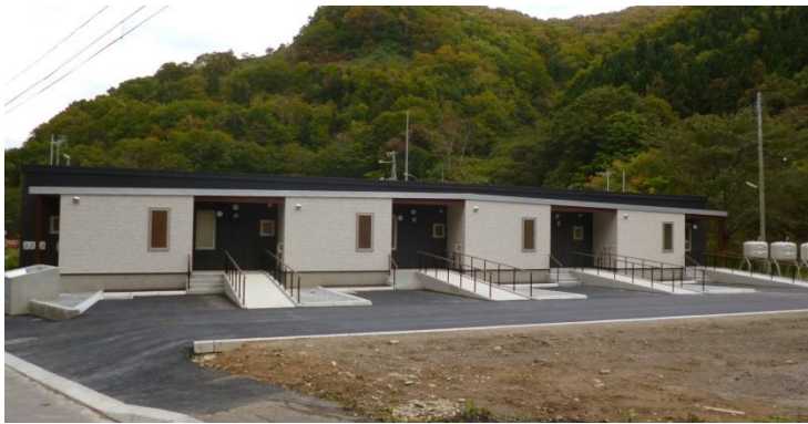
奥尻町公営住宅たかのす団地 (2015)
