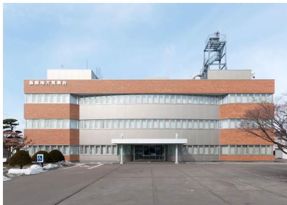
函館海洋气象台改修 (2014)
