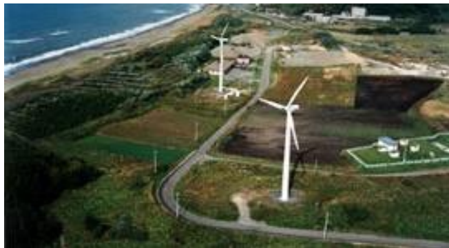
基礎工事 2 基（元請） 平成 9 年 1 1 月完成
