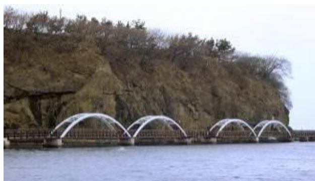
橋脚工事（元請） 平成 1 1 年 2 月完成
