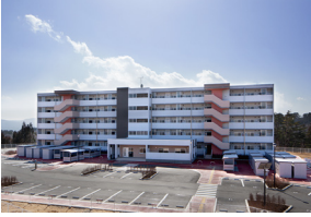
復興公営住宅新築工事
