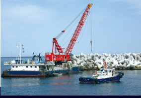
消波ブロック設置工事
