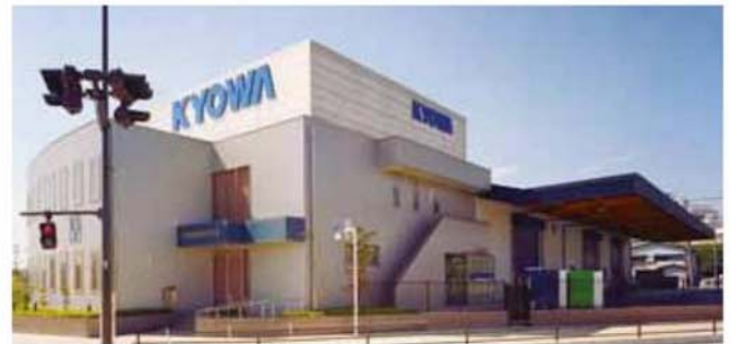
共和商事本社ビル 埼玉県八潮市
