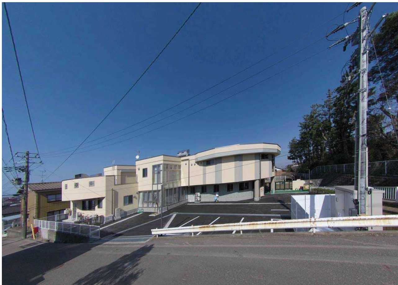
（松崎保育園新築工事）
