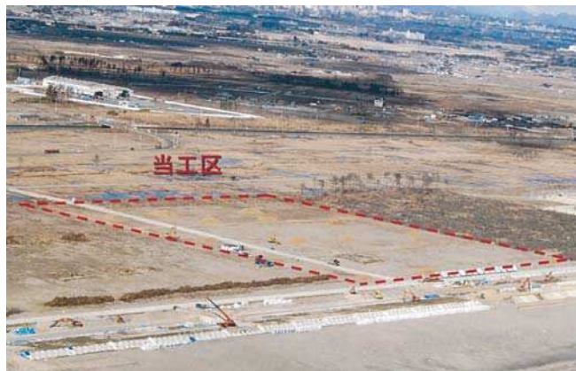
名取地区第六治山工事
