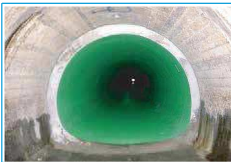
(かんがい排水事業三面川左岸第3次工事)
