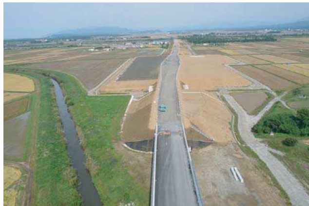
日東道 環境対策その2工事
