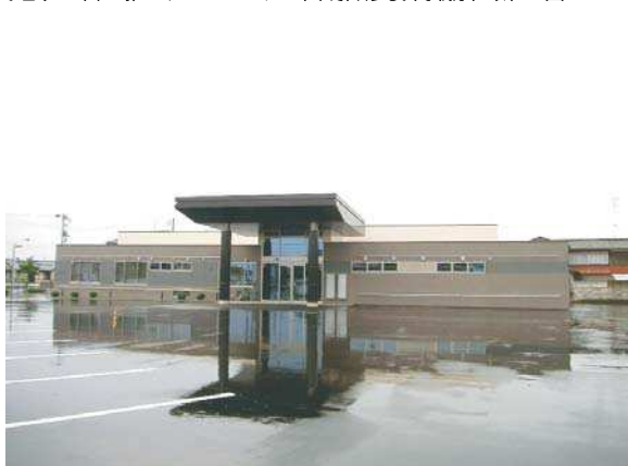
JA虹のホール荒川建築工事
