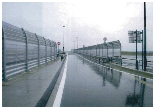
日東道 地吹雪防止柵新設工事
