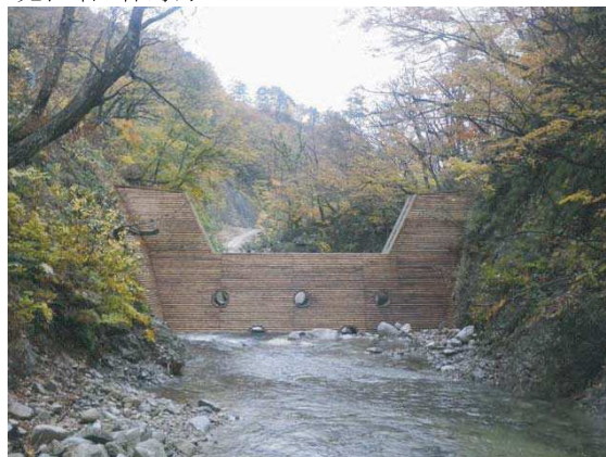
藤沢川治山工事
