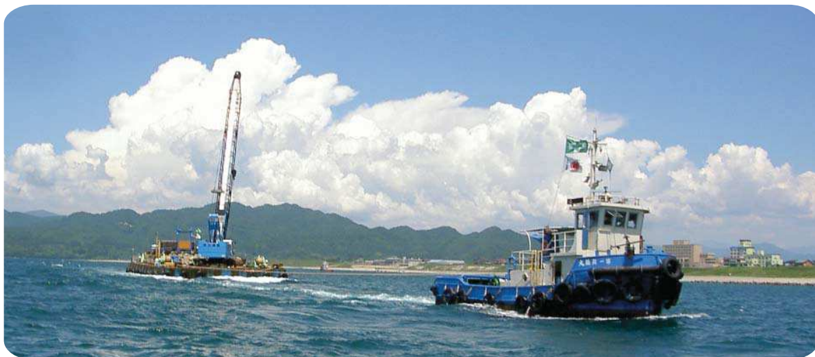
瀬波海岸海岸侵食対策(人工リーフ)工事
