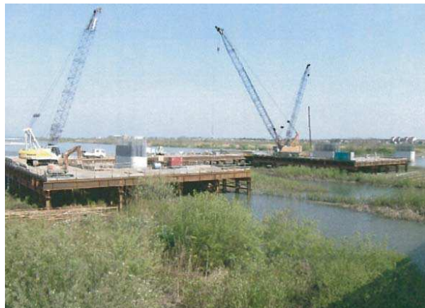
一般国道345号線 旭橋下部工工事
