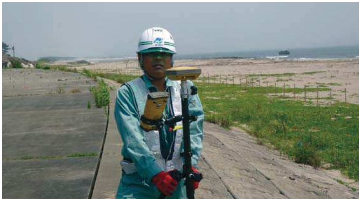
東松島州崎地先海岸復旧工事
