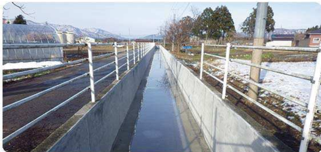
(三面川左岸地区第20次工事)
