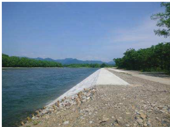
二級河川三面川23年災河川災害復旧工事
