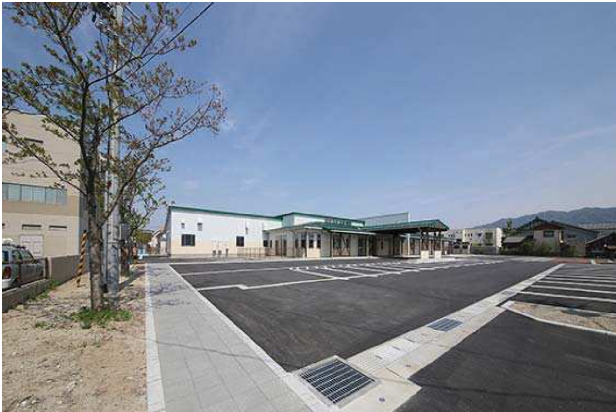
（荒川統合保育園建設工事）
