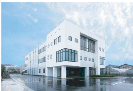
村上市生涯学習推進センター建設(建築本体)工事
