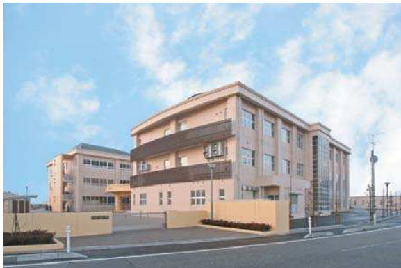
山辺里地区統合小学校建設(建築本体)工事
