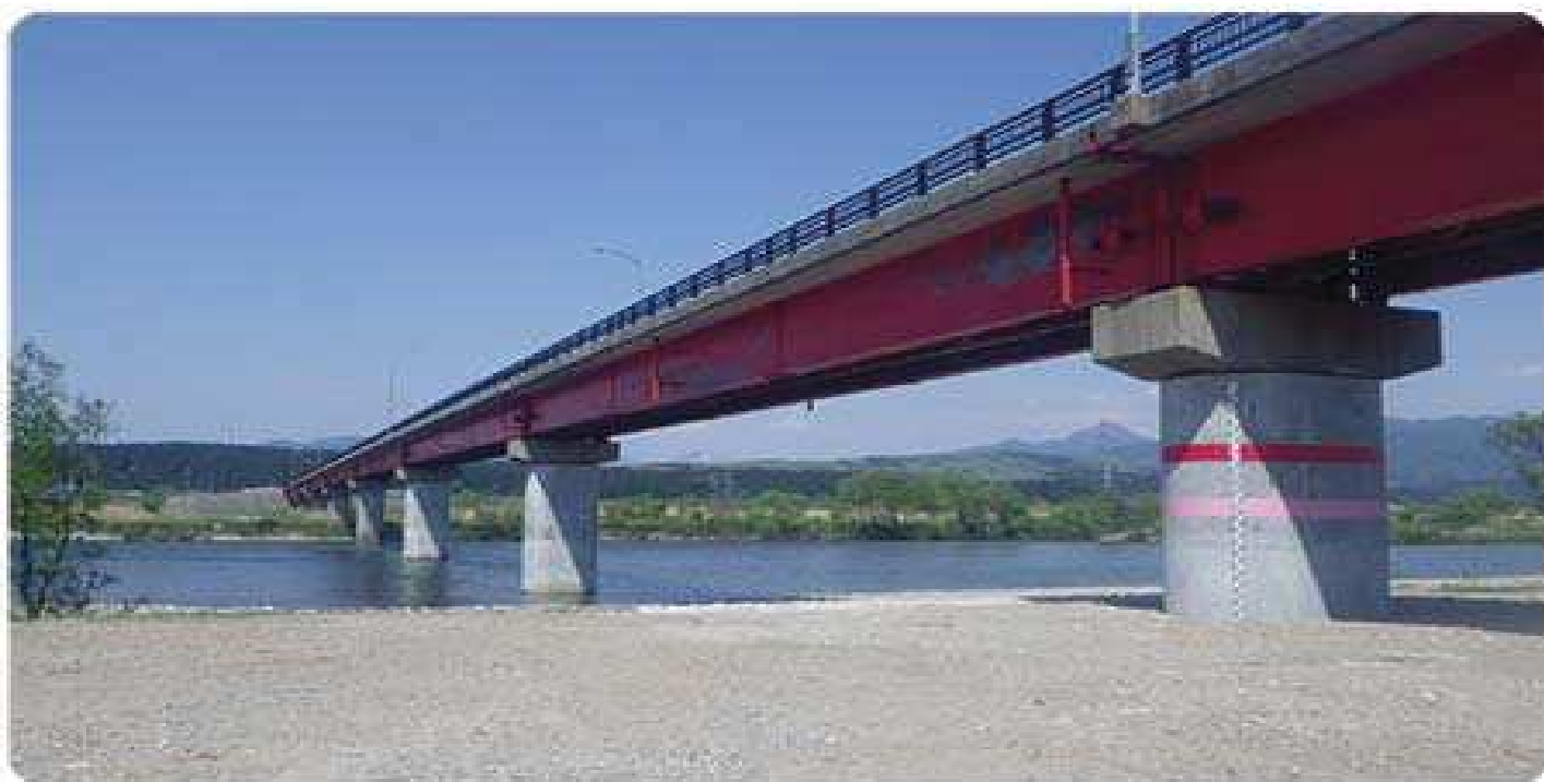
(高田橋耐震補強工事)
