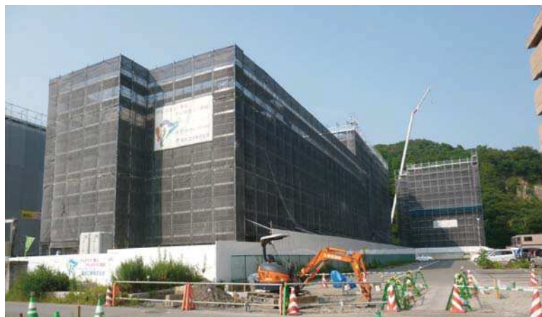
災害公営住宅新築工事（吉野一丁目）
