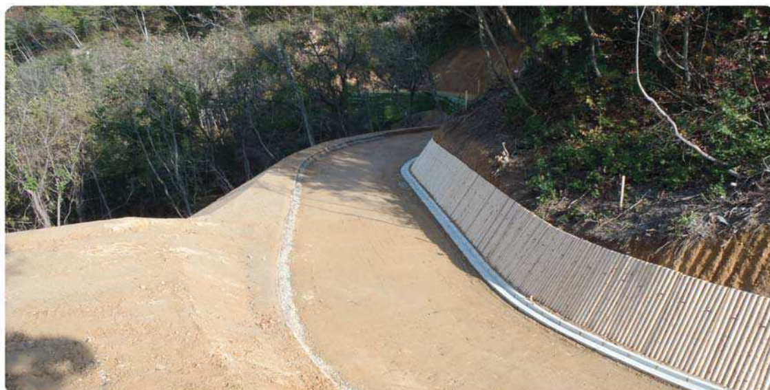
(海府南線羽下ヶ渕工区開設工事)
