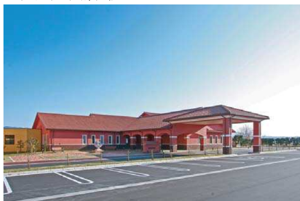
佐藤医院新築工事
