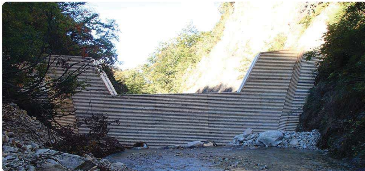
（藤沢川復旧治山工事）
