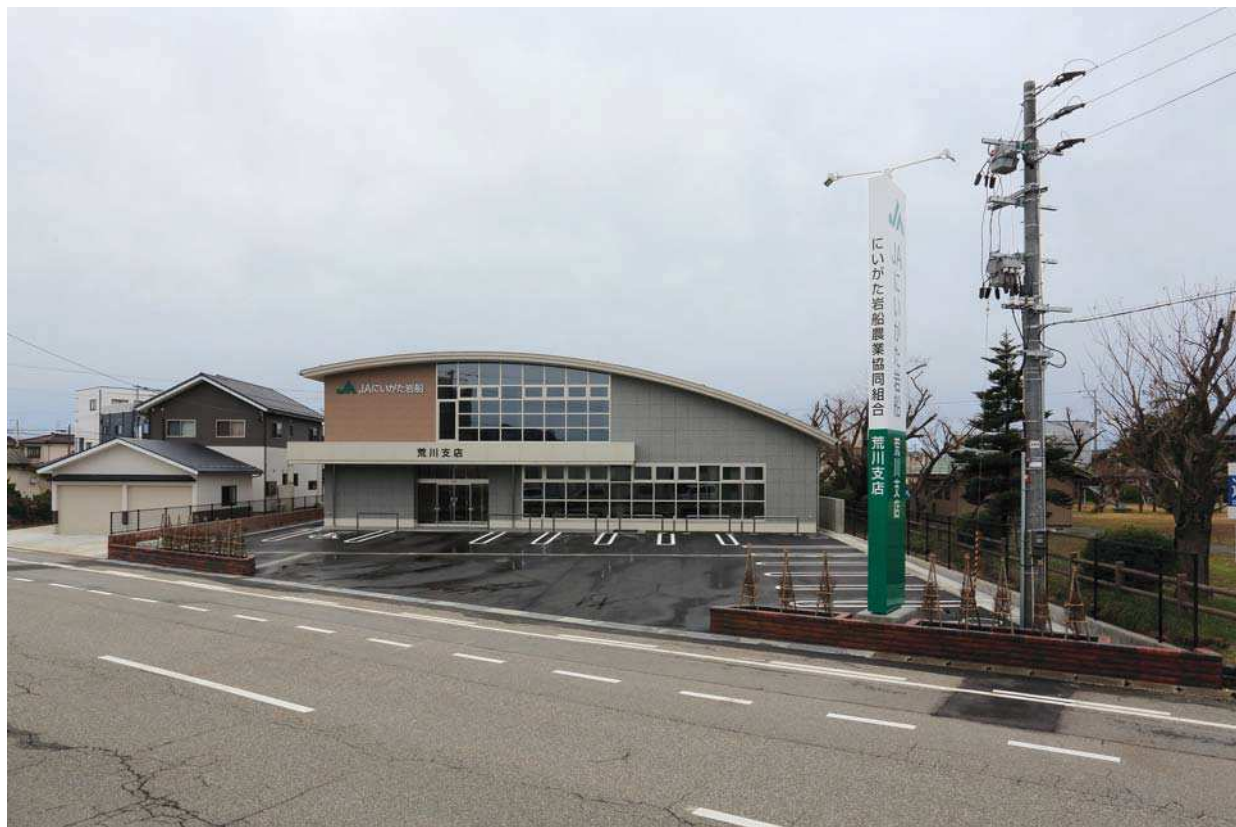
(JAにいがた岩船 荒川支店建設工事)
