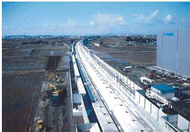
北陸新幹線、富山水橋開発高架橋工事
