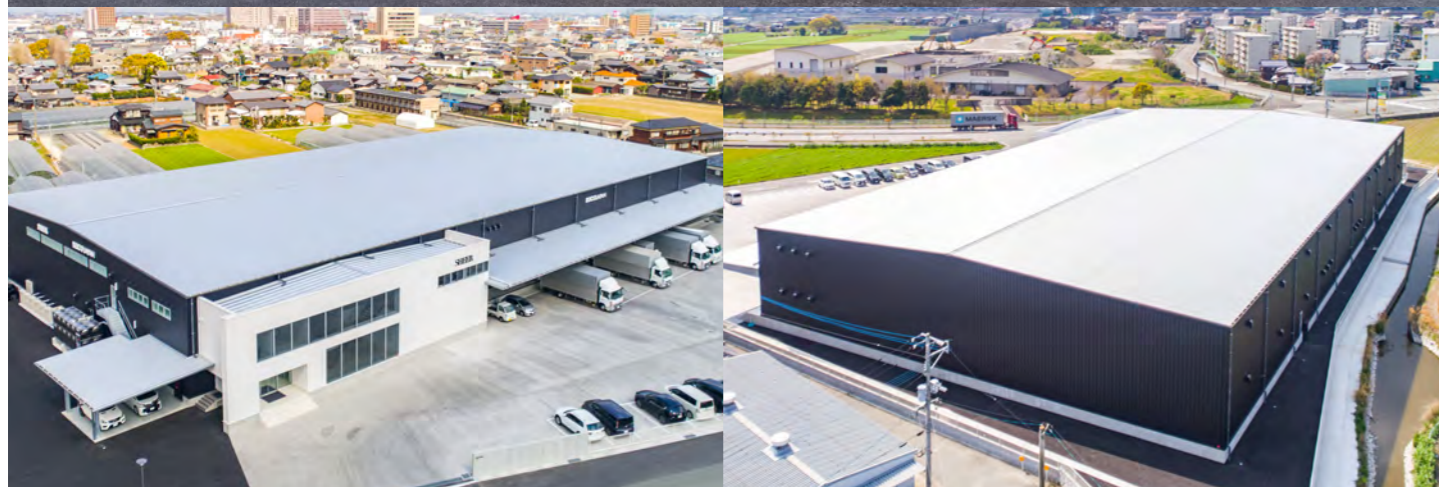
▶ 事務所兼倉庫
