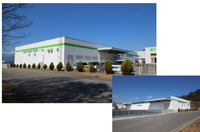
大和グラビヤ(株)南アルプス工場新原紙倉庫棟
