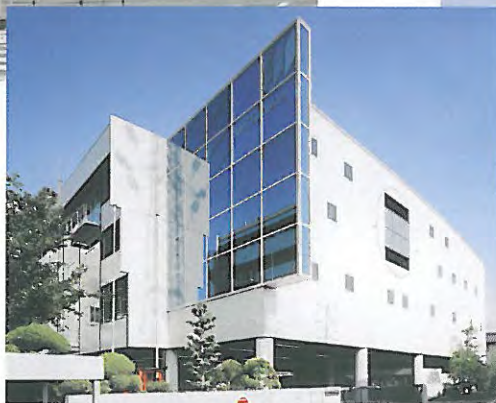
松浪硝子工業(株)本社工場
