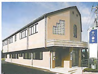
下松メディカルビル
