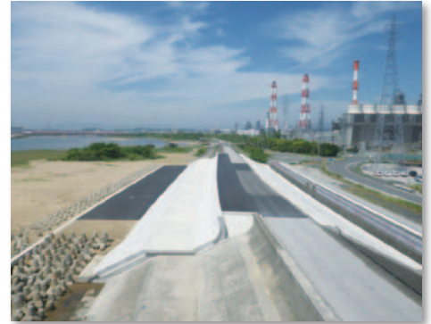
▲ 平成24年度 鈴鹿川石原高潮堤防工事 (場所：四日市市)
