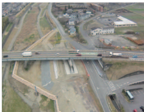
▲平成 25 年度 258 号多度地区橋梁下部工事 (場所：桑名市)
