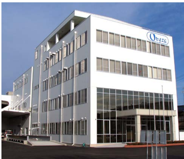
▲ オリザ油化（株） 事務所棟・工場棟 【HACCP 採用】
