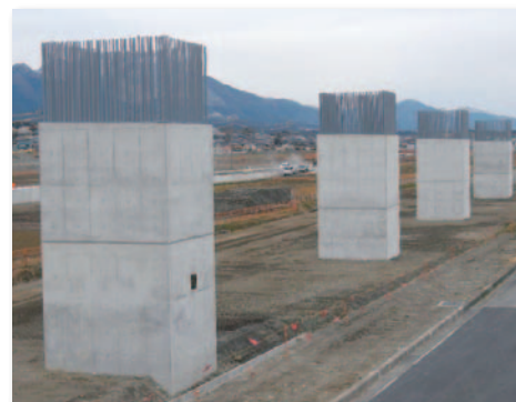
▲平成 25 年度 東海環状員弁大安高架橋南下部工事 (場所：いなべ市)
