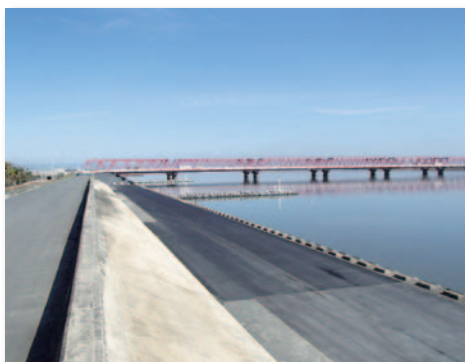
▲平成 26 年度 木曽川福吉川表高潮堤防補強工事 (場所：桑名市)
