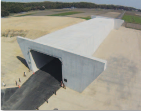
▲ 平成24年度 北勢 BP 西坂部道路建設工事 (場所：四日市市)
