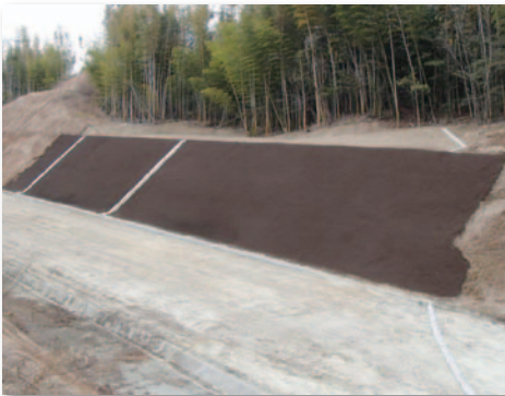
▲ 平成24年度 北勢国道管内道路設備工事 (場所：四日市市、亀山市、東員町)
