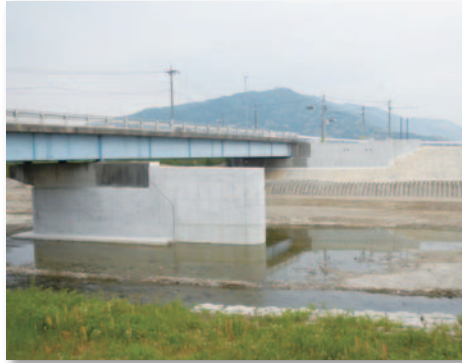
▲ 平成24年度 258 号新脇江橋下部工事 (場所：桑名市)
