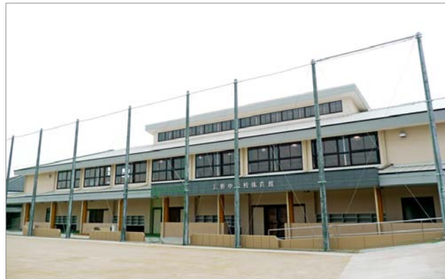
▲菰野町立菰野中学校 体育館
