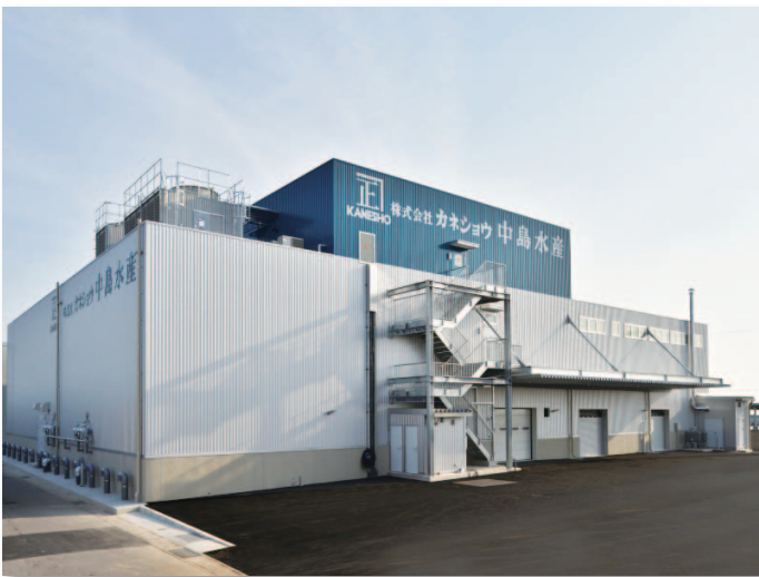
▲（株）カネショウ中島水産 水産加工工場
