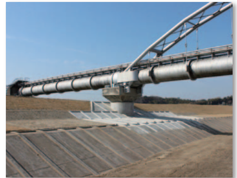
▲ 平成 23 年度 内部川水管橋下部補強工事 (場所：四日市市)
