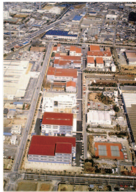
▲ 太陽化学（株） 塩浜工場 全景
