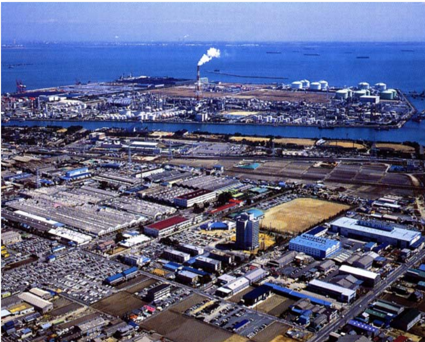
▲ 富士電機（株） 三重工場 全景
