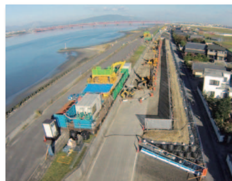
▲平成 26 年度 木曽川木曽岬源緑川裏高潮堤防補強工事 (場所：桑名郡木曽岬町)
