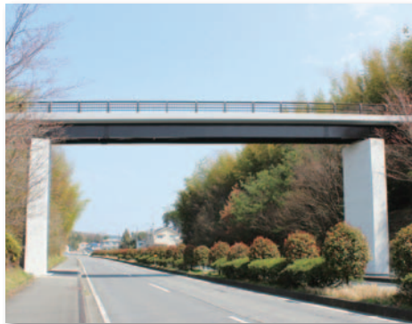
▲ 平成24年度 23 号津管内橋梁補修工事 (場所：鈴鹿市～伊勢市)
