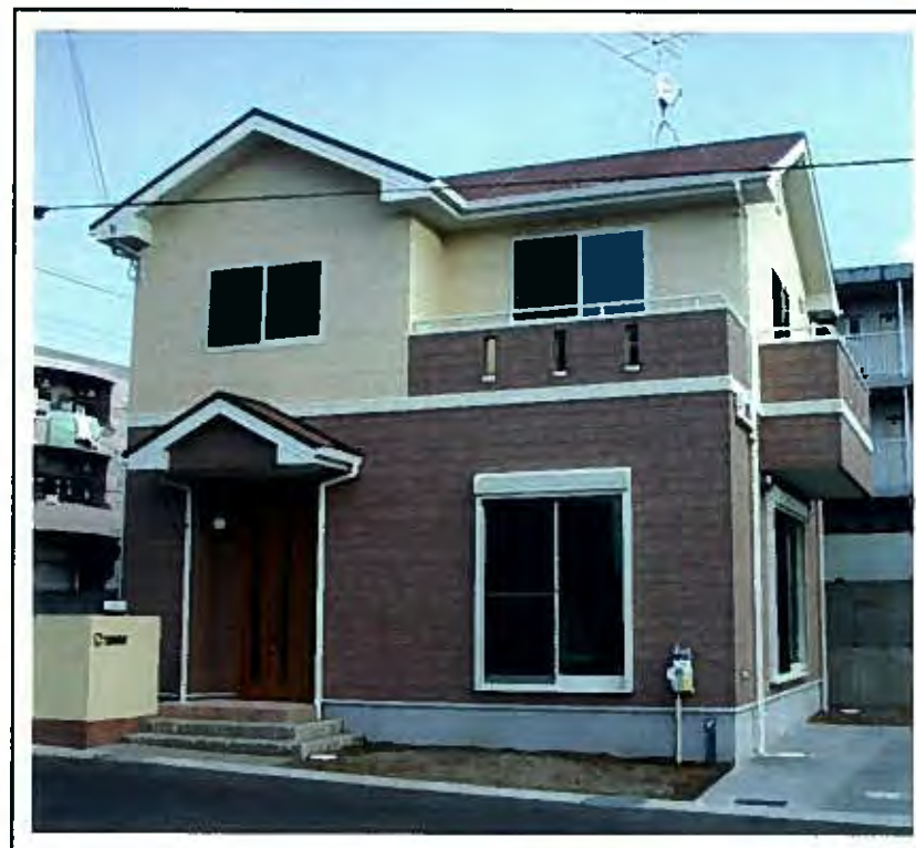
原田邸 新築工事
