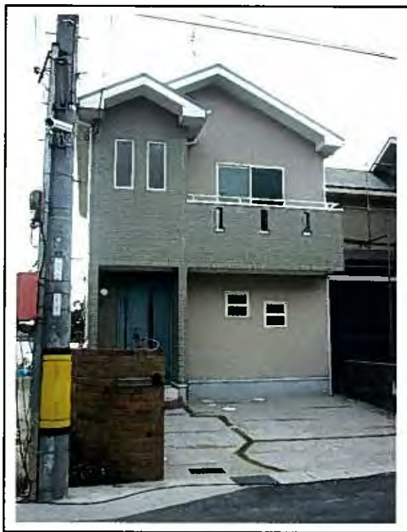
高野邸 新築工事
