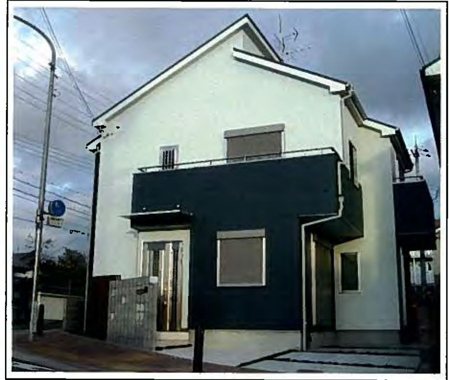
入江邸 新築工事
