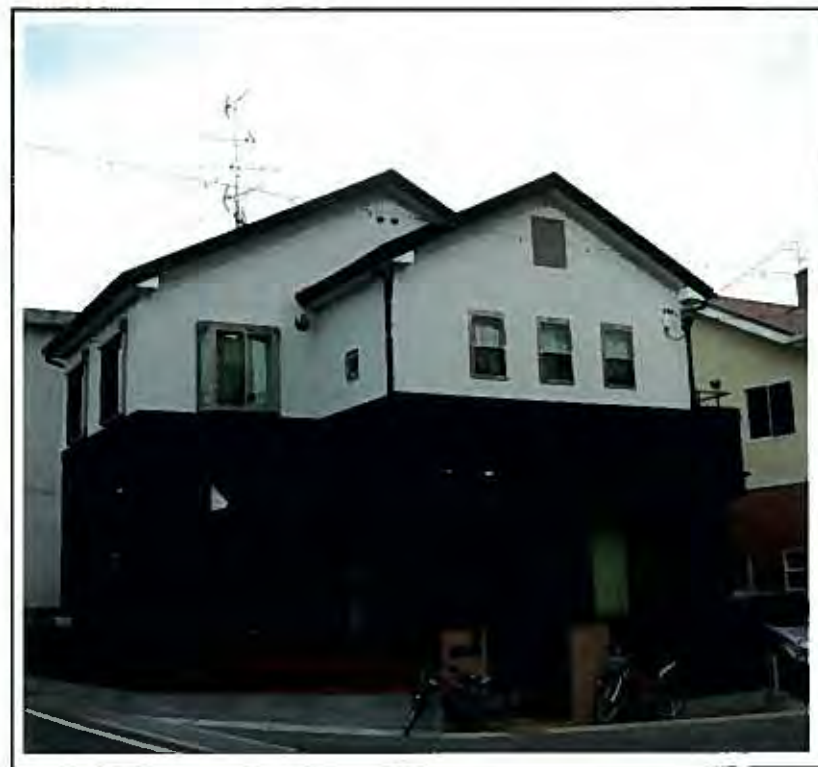
中岡邸 新築工事
