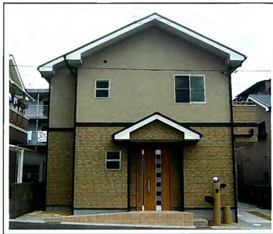
大谷邸 新築工事
