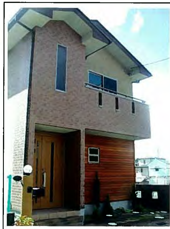
片山邸 新築工事
