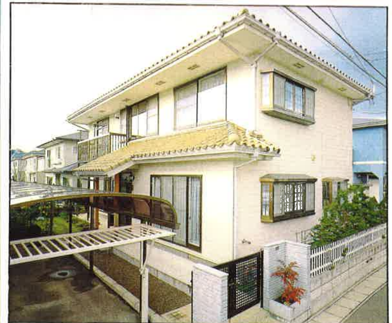
△盛岡市水道部建築工事 ▽個人住宅建築工事
