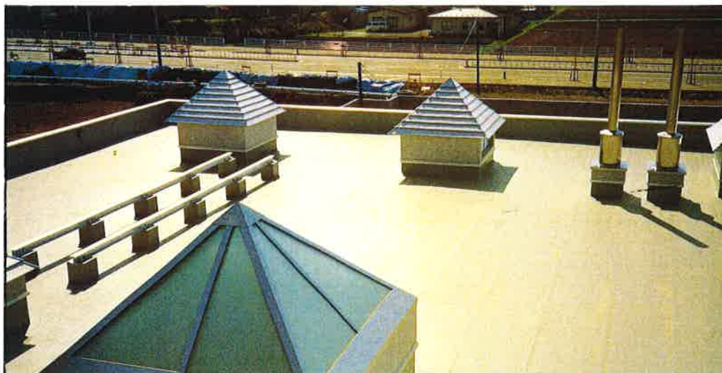
△盛岡市立上田小学校建築工事 ▽高度技能技術専門学校防水施工工事
