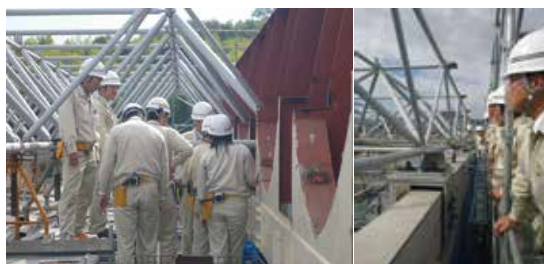
【段階別研修の様子】 現場構造見学研修
