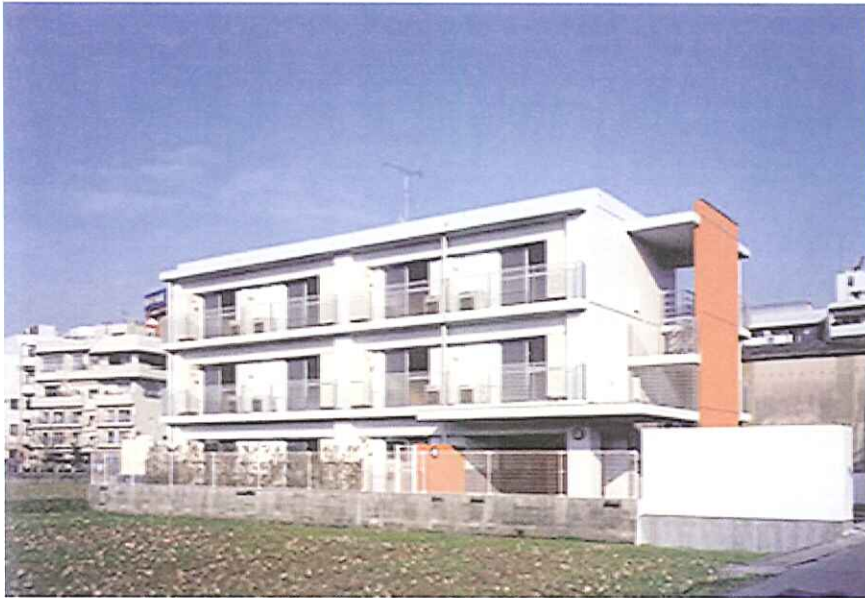
■ 那珂川病院清和寮【設計／(株)三島設計事務所】 (福岡市)
