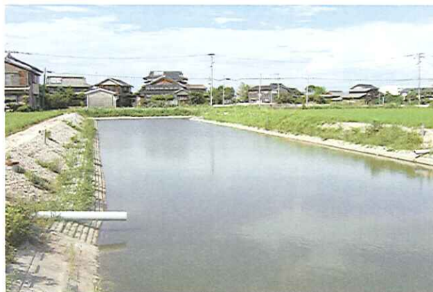
平成17年度起工第3号 クリーク防災機能保全事業(大川東部地区)水路工事 (大川市)
