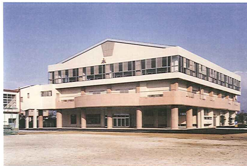
□ 大川市立大川東中学校屋内運動場【設計／榑内藤建築設計事務所】 (大川市)
