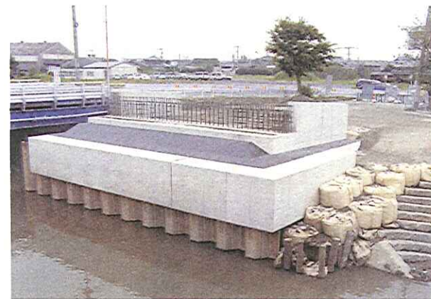
花宗川(向島地区)花宗橋 下部工工事1工区(広域基幹) (大川市)
