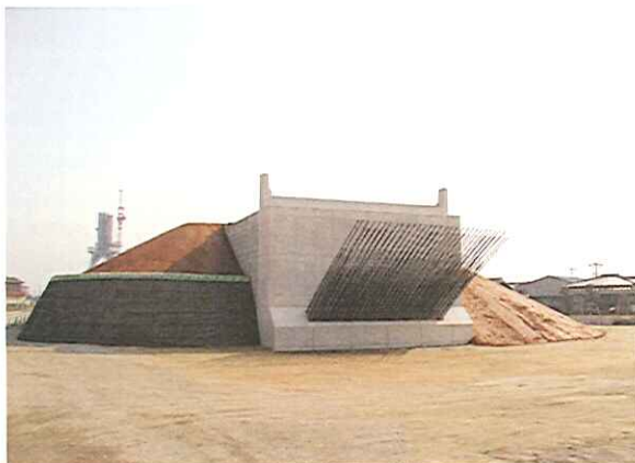
福岡208号 皿垣連続高架橋下部工(A1~P5)工事 (福岡国道事務所長表彰) (柳川市)
