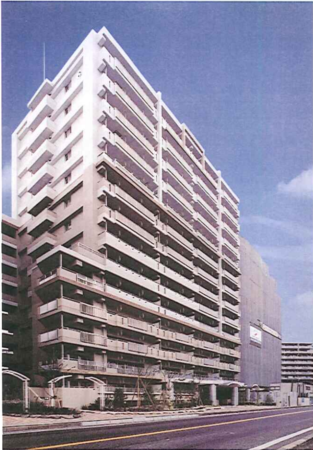
□アーベインビオ春日8ブロック (都市再生機構九州支社長表彰) (春日市)
