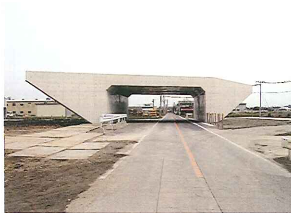
福岡208号 西蒲池地区改良10-2工区工事 (柳川市)
