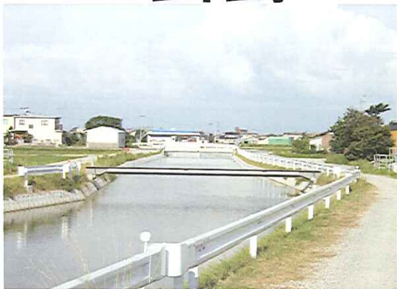
平成16年度筑後川下流農業水利事業 幹線水路昭代2号線(九網上流工区)工事 (大川市)
