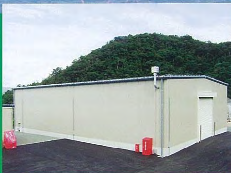
大阪化学薬品様危険物庫新築工事
