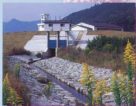
勅使樋門水路その他工事(国土交通省)
