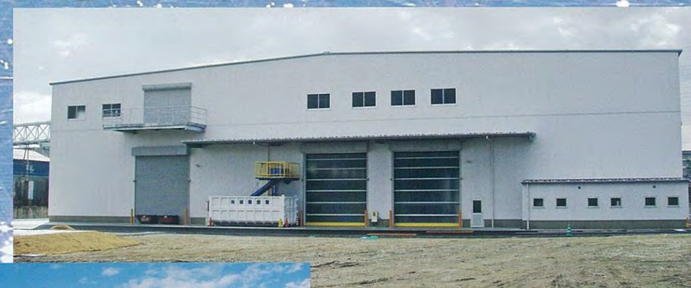
黒田製作所様工場新築工事
