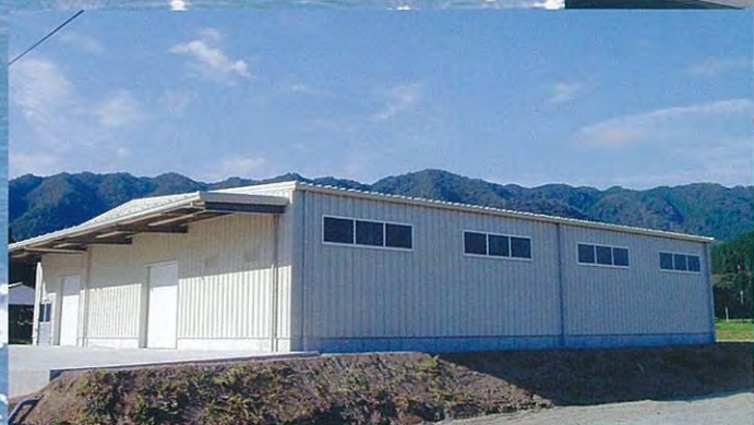
ホルベイン画材様兵庫物流センターC館倉庫新築工事
