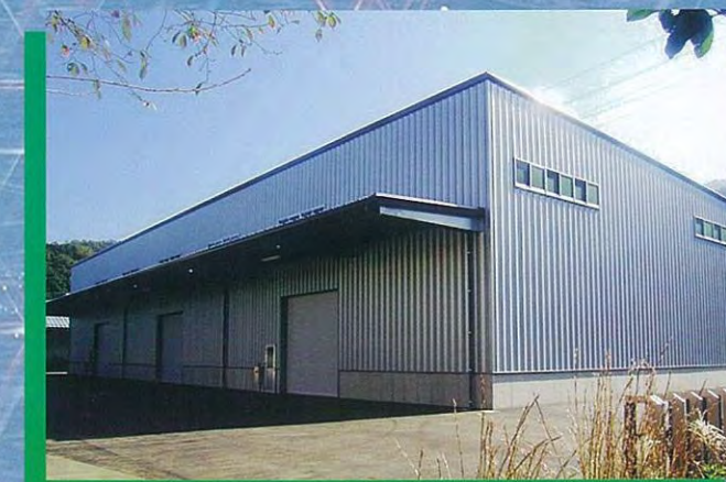
日本海精練様倉庫新築工事
