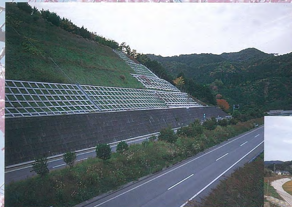
京都丹波道路亀岡地区法面防災対策工事(日本道路公団)
