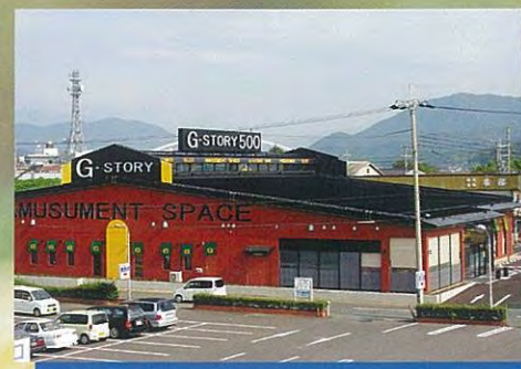
G-STORY500改築工事
