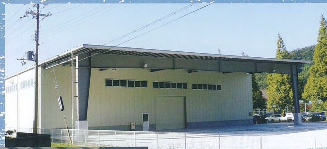
丸玉産業様第四期倉庫新築工事
