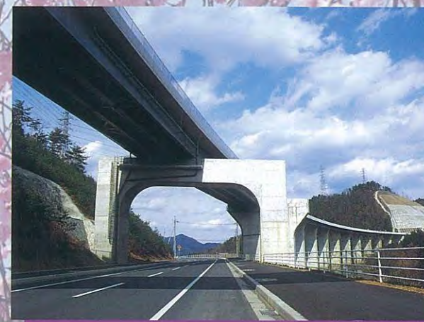
近畿自動車道舞鶴線福岡山工区道路築造工事(日本道路公団)
