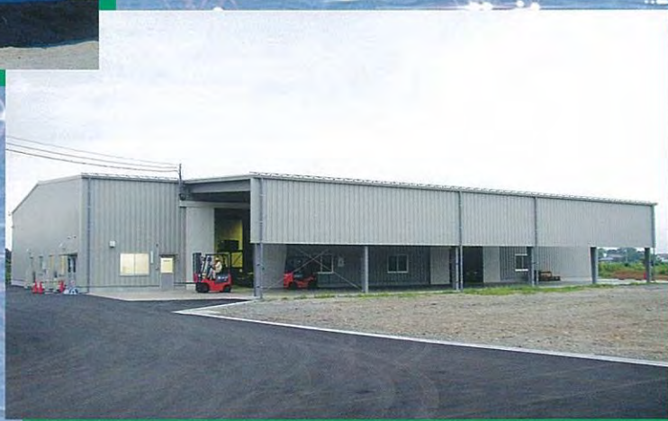
伊吹正化学工業様倉庫棟新築工事
