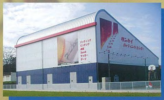
サンケイスポーツドーム新築工事
