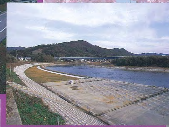
土師川河川災害復旧助成工事(京都府)
