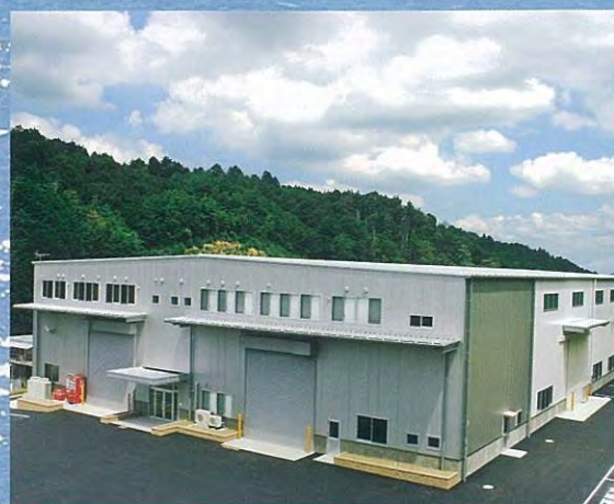
中央技建工業様工場新築工事
