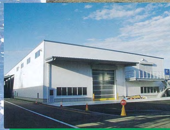
黒田製作所様金型研究所新築工事
