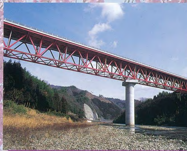
第1由良川大橋下部(その1・2)工事(国土交通省)
