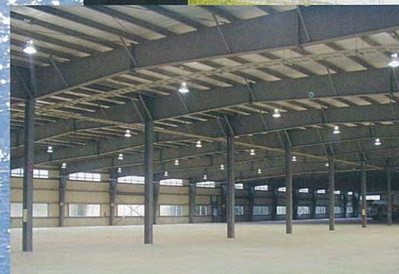
丸玉産業様舞鶴工場棟新築工事
