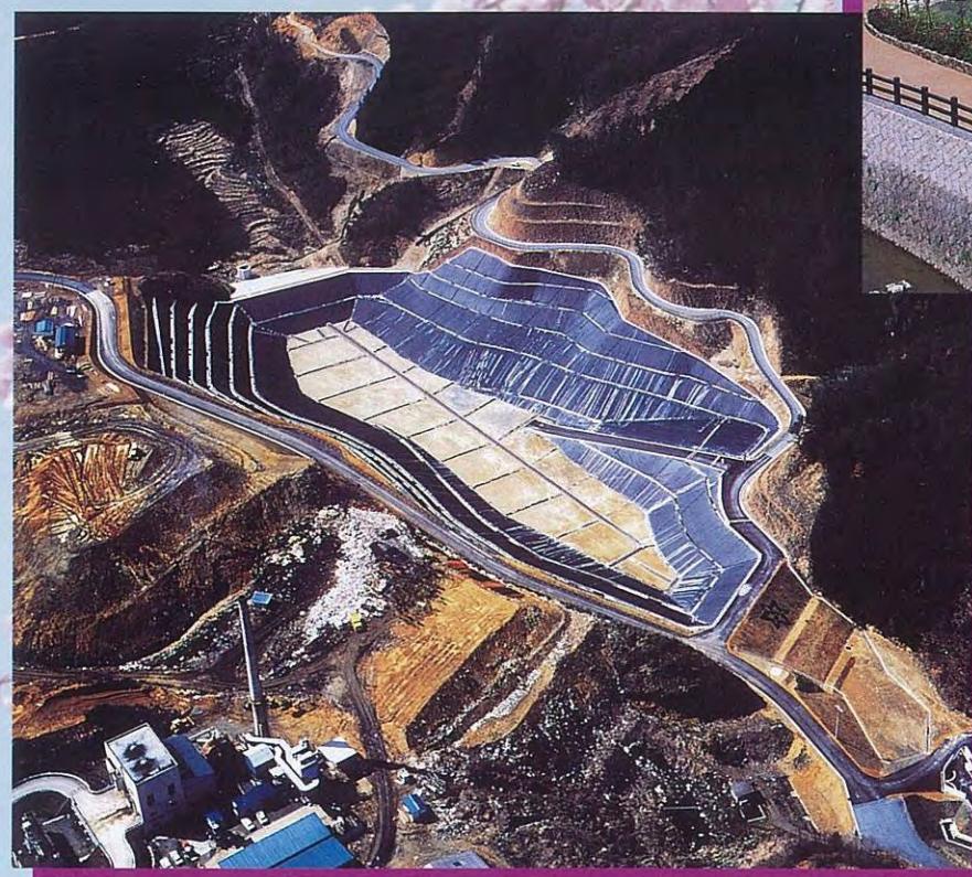
不燃物埋立処分場整備事業埋立地造成工事(福岡山市)
