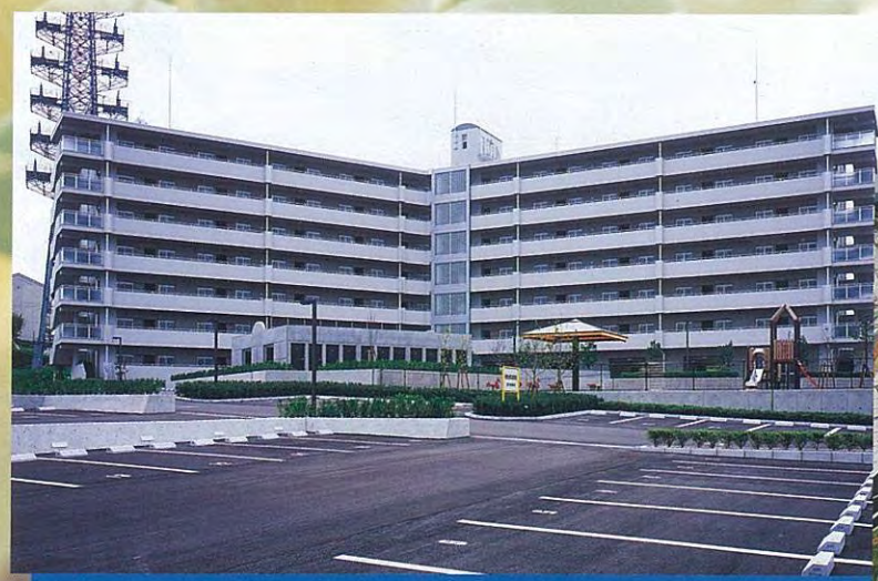
府営住宅福知山駅南団地建設工事(京都府)
