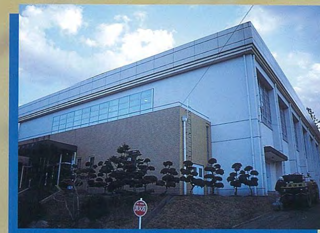
福知山成美高等学校体育館新築工事
