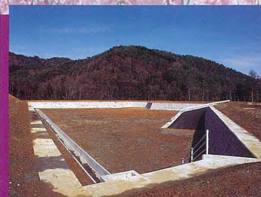
三和町綿の谷工場用地造成工事(福岡山市土地開発公社)
