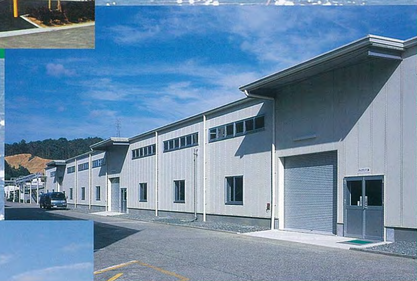
ウエスト電気様新工場棟新築工事
