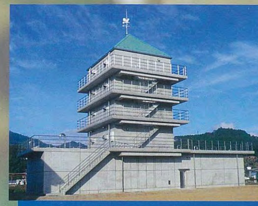
下荒河浄水場水槽棟建築工事(福知山市)
