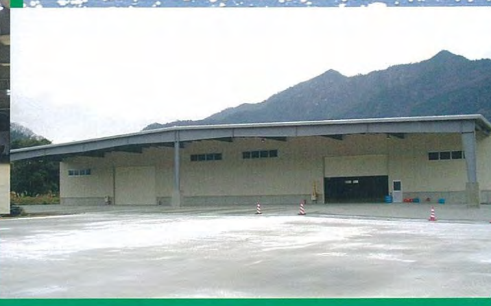
丸玉産業様舞鶴工場棟新築工事
