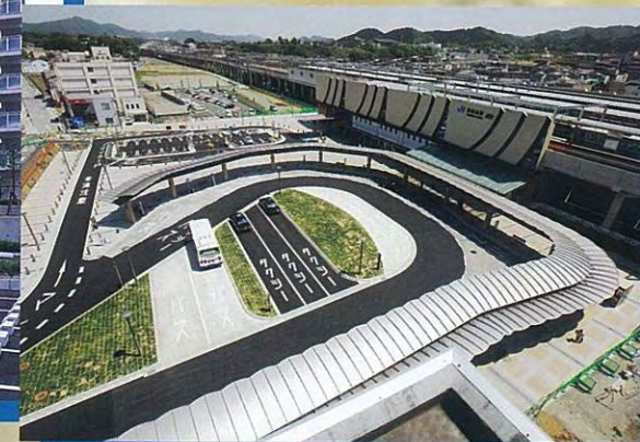
福知山駅北口シェルター設置工事(福知山市)
