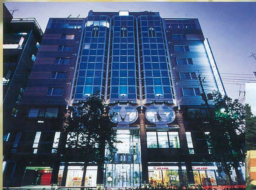
京都リノホテル新築工事
