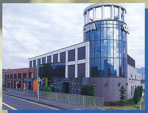
パチンコオーバ新築工事
