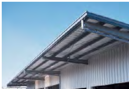
鉄骨現わし大庇
