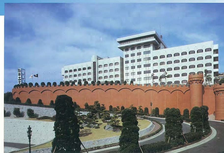
崇城大学(旧熊本工業大学) 本館及び電子電気工学科棟
