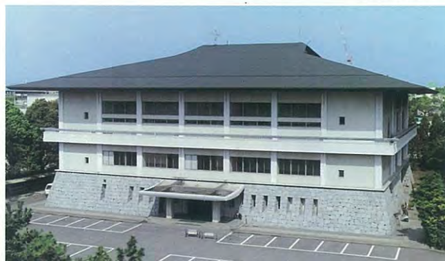
熊本県立武道館
