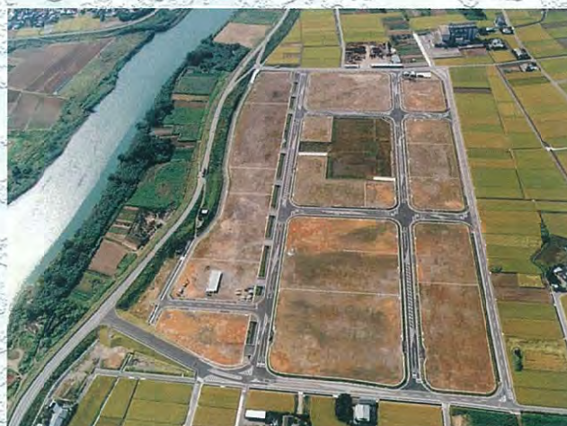
嘉島リバゾン 敷地造成完了
