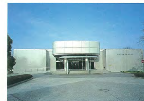
電子応用機械研究所(テクノリサーチパーク内)
