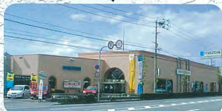
熊本マツダ本社 外壁改装
