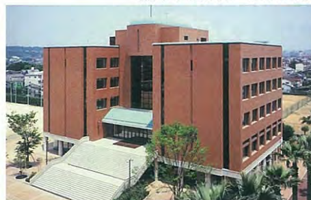
熊本学園大学 12号館
