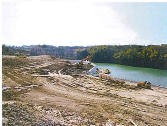
▲ 宅地造成工事の様子
