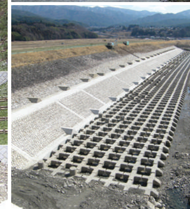
平成23年度天竜川東伊那郡岸工事▲
