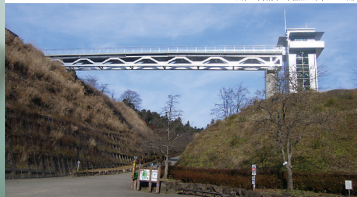
平成20年度都市公園整備工事（ふれあい橋）▼
