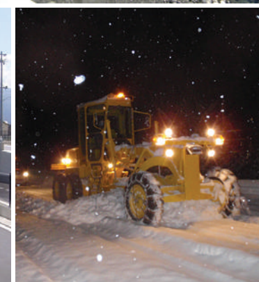
国県道緊急除雪作業▲
