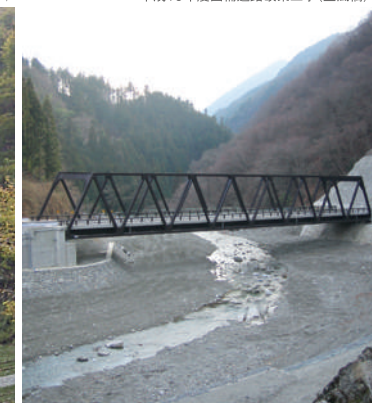
平成19年度国補道路改築工事（豆嵐橋）▼
