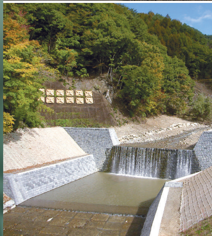
平成21年度天竜川水系唐山沢砂防林3号床固工工事▲
