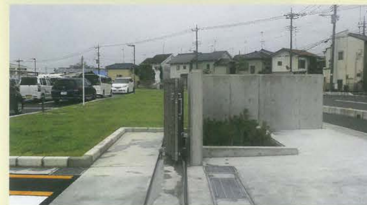
外構土木工事
