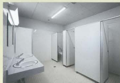
給排水改修工事
