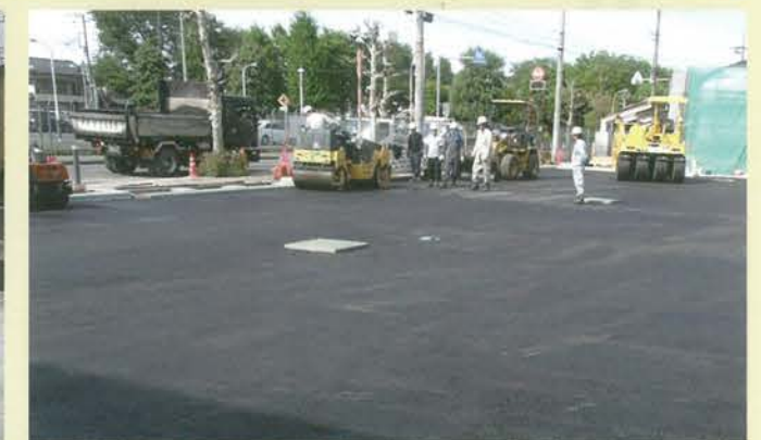
駐車場 舗装工事
