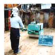
浄化土埋戻し転圧
