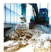
密閉負圧施設内汚染土浄化
