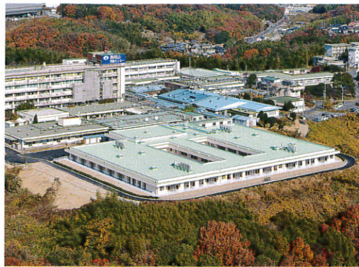
国立病院機構南岡山医療センター (岡山県早島町) 病院 重心病棟 鉄筋コンクリート造 地上1階建
