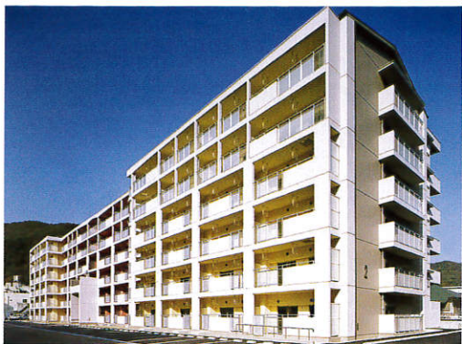
県営住宅伊部団地 (岡山県備前市) 共同住宅 鉄筋コンクリート造 地上6階建
