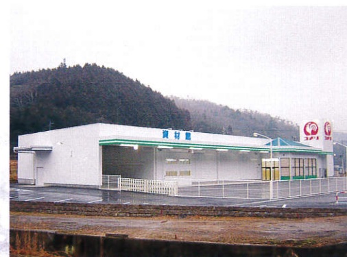
株式会社 コメリH&G加茂川店 (岡山県吉備中央町) 店舗 鉄骨造 地上1階建
