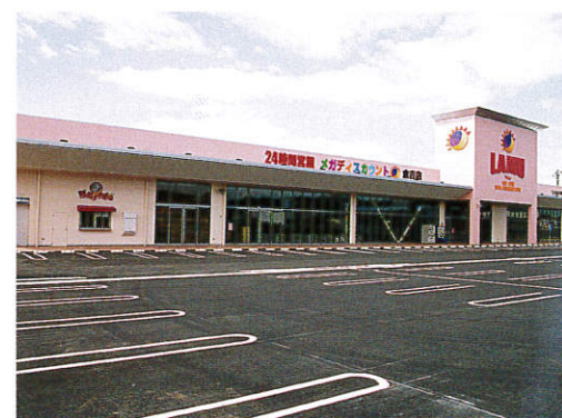
大黒天物産株式会社 ラ・ムー倉吉店 (鳥取県倉吉市) 店舗 鉄骨造 地上1階建
