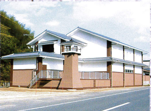
美作市美作浄化センター (岡山県美作市) 下水道処理施設 鉄筋コンクリート造 地下1階、地上2階建
