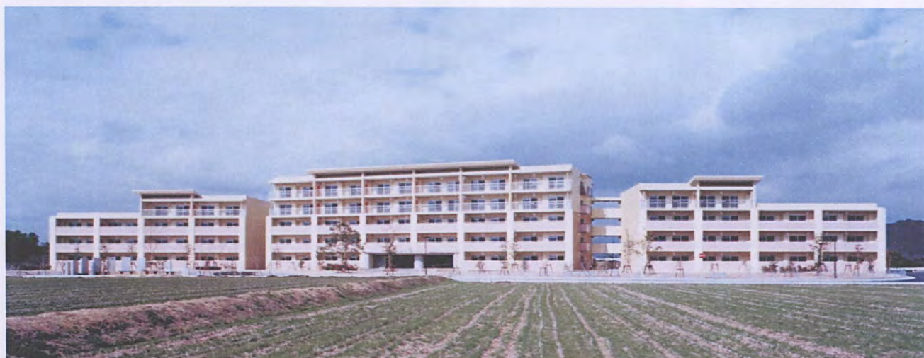
小郡市営井上第一住宅
