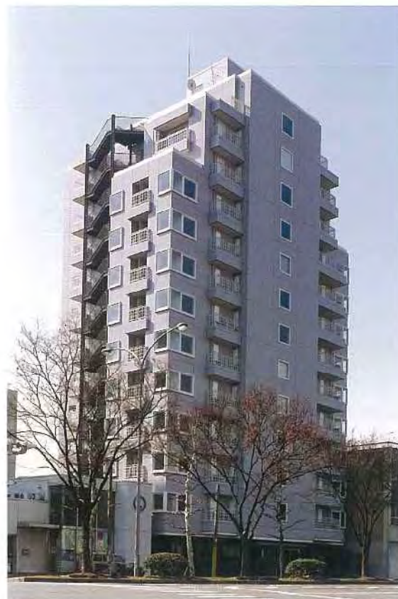
パインフィールド御池
