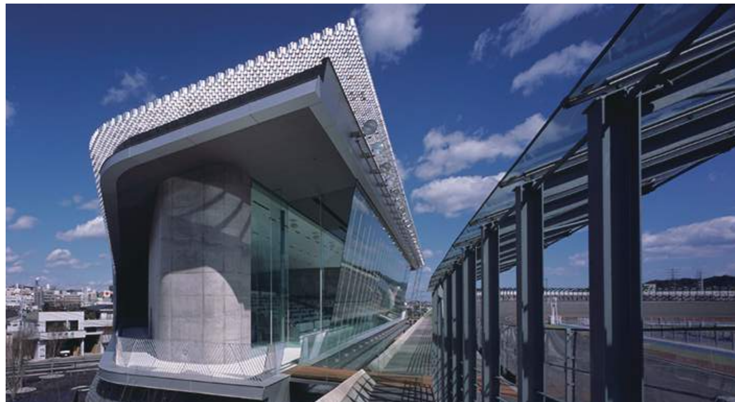
いわき平競輪場 地域開放型施設
