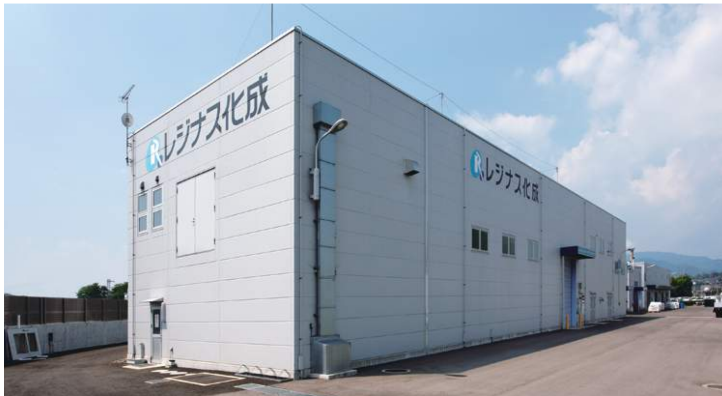
レジナス化成株式会社 第3工場・危険物倉庫
