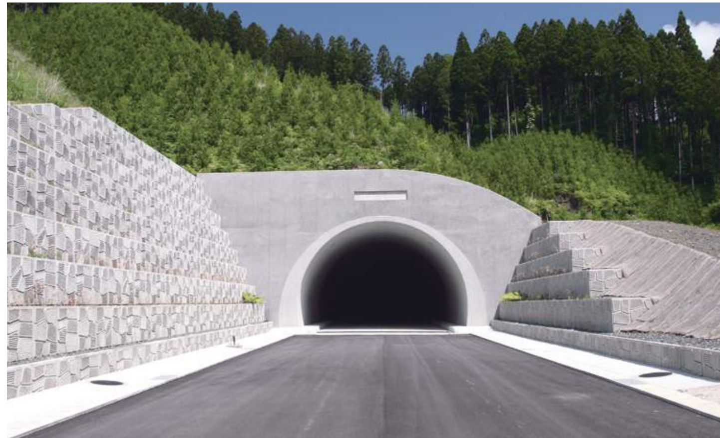
国道289号線荷路夫トンネル
