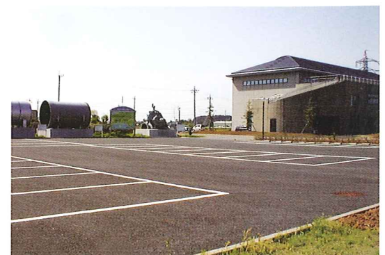
駐車場外構工事
