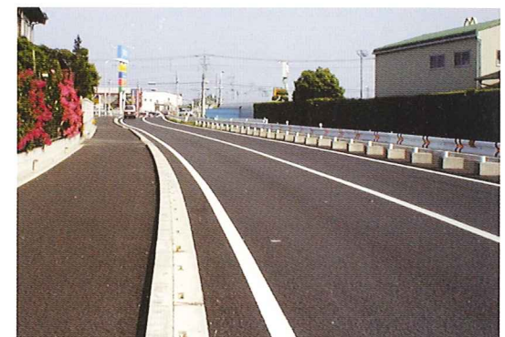
道路舗装工事
