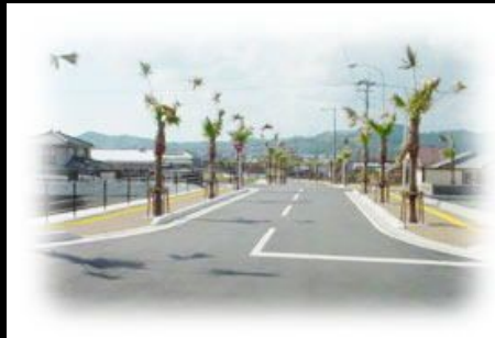
道路改修工事
