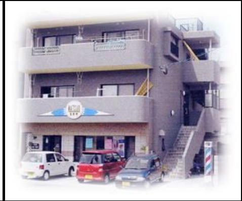
鉄筋コンクリート造（店舗付2世帯住宅）
