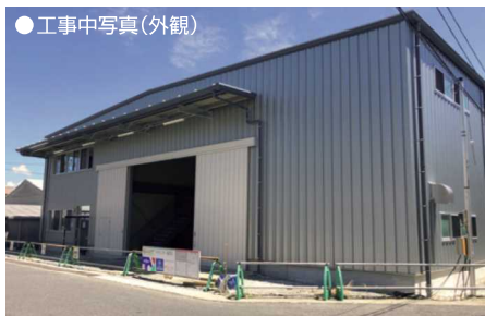
● 工事中写真(外観)
